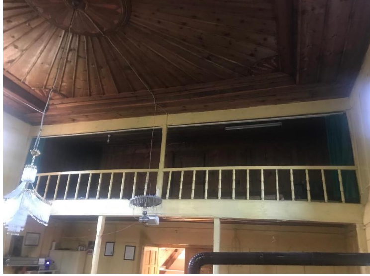
Resim 53: Karandı köyü camii iç görünüm
