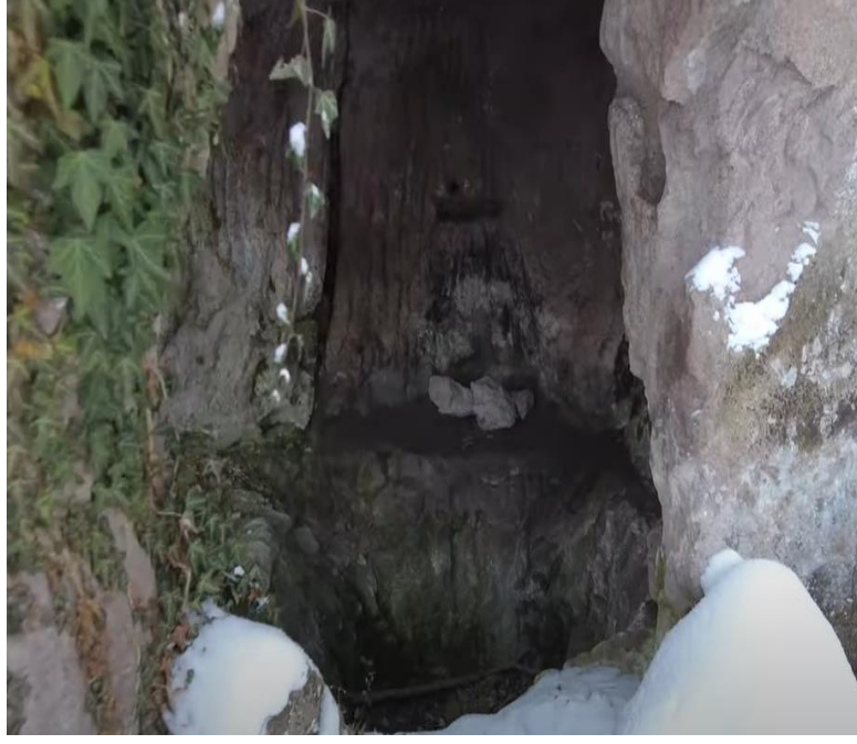
Resim 19: Sipahiler köyü gavar evi alt kat iç görünümü
