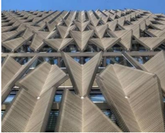
Şekil 3.4. Thyssen Krupp HQ
