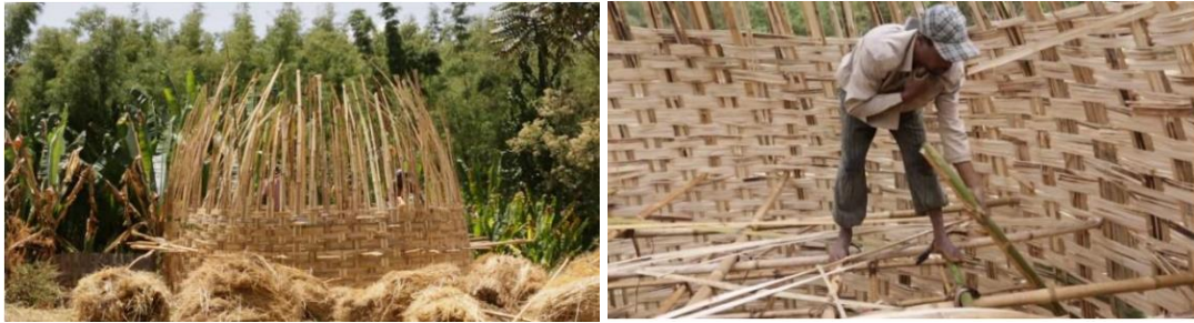
Şekil 3.73. Gamo evinde duvarın örülmesi ve iskele yapısının eklenmesi.
