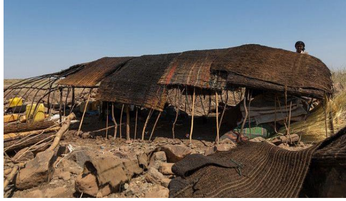
Şekil 3.42. Afar evinin havalandırma Açıklıkları.
