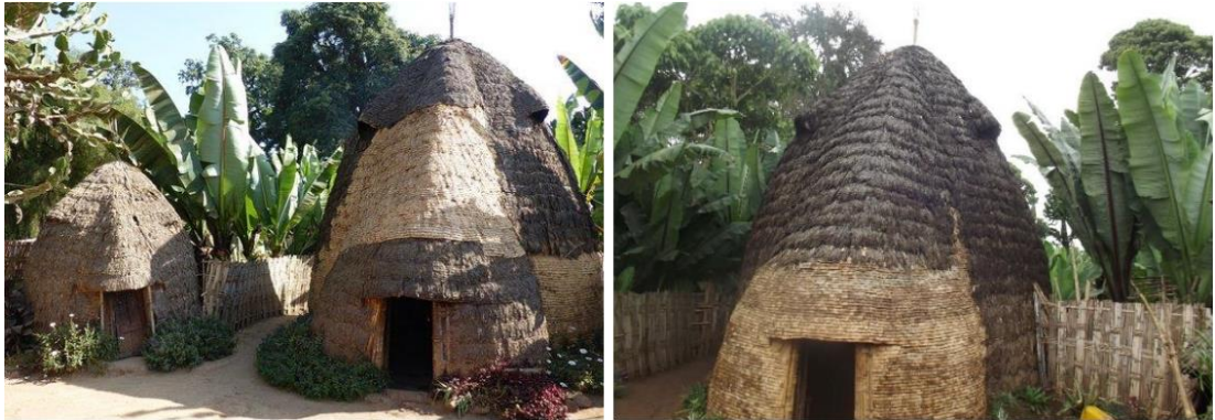
Şekil 3.78. Gamo evinde çatı kaplama malzemesinin değişimi.
