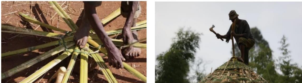
Şekil 3.74. Gamo evinde konut çatısının tepe noktasının tamamlanması.
