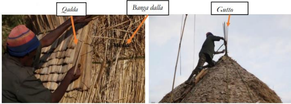
Şekil 3.76. Gamo evinde çatı bölümünü kaplayan bambu yaprağı ve çatının üst kısmına gutto eklenerek evin bitirilmesi.
