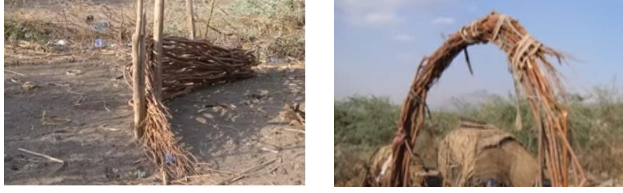
Şekil 3.43. Afar konut inşasında kullanılan kurutulmuş ve eğilmiş ağaç dalları.
