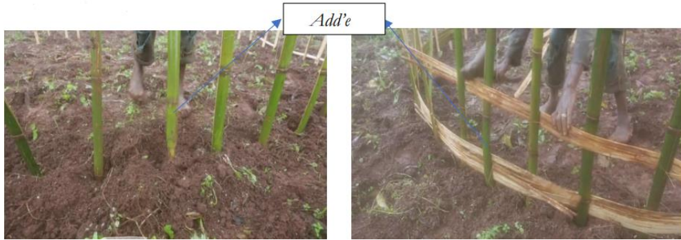
Şekil 3.71. Gamo evinde Add'e direğinin çevrelenmesi ve yatay bambu elemanların dokunmaya başlaması (Ezo, 2019).
