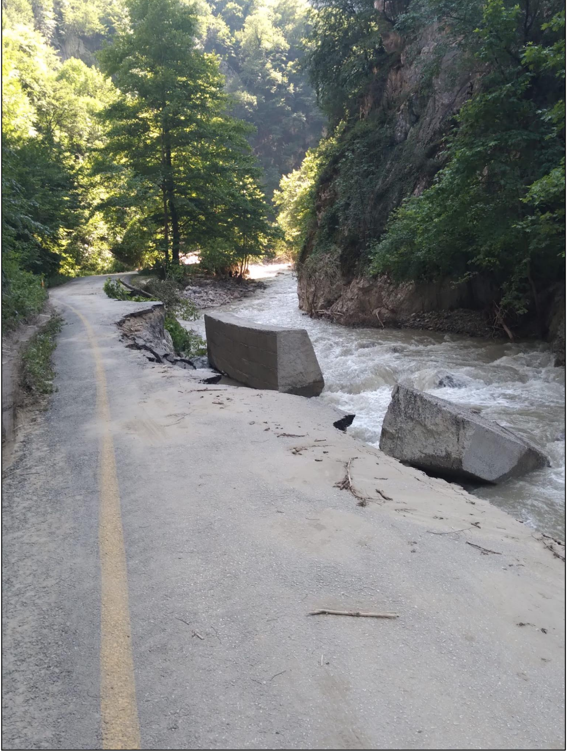
Fotoğraf 34: Şimşirderesinin Filyos Çayı'na bağlanmadan önce Şeker deresi adını aldığı bölümde taşkınların yaşanması yolu kullanılamaz hale gelmiştir.
