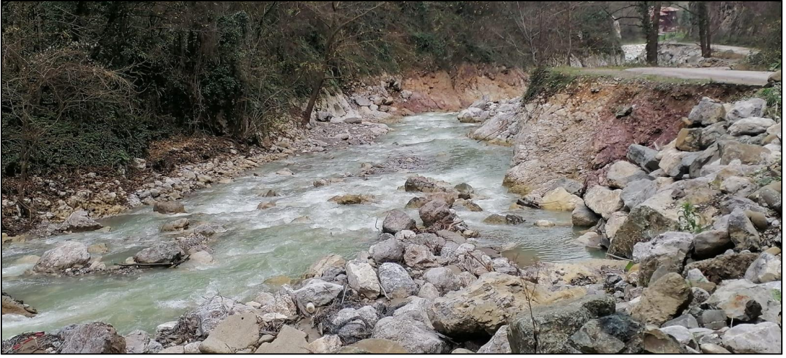
Fotoğraf 42: Şimşirderesi, Şeker Kanyonu yakınlarında Şeker Deresi adını almaktadır.
