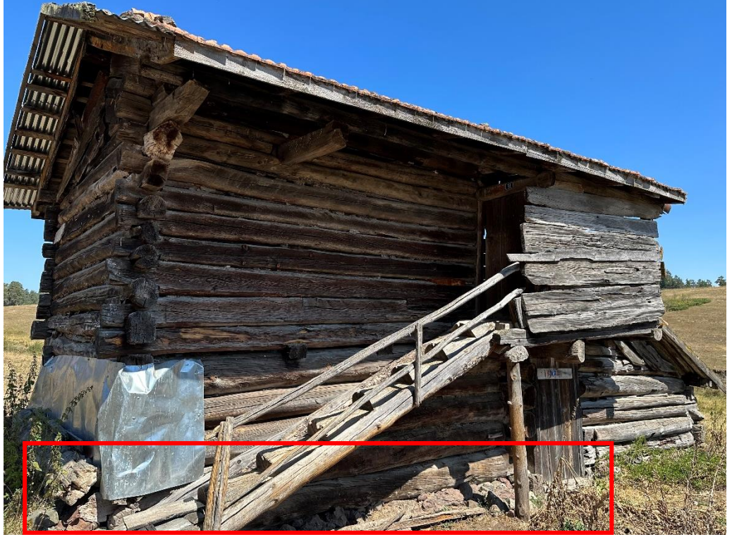
Şekil 4.79. Gölcük yaylası 18 nolu konut, ahşap yığma duvarın oturduğu taş temel.
