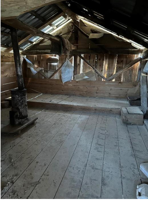
a) Odanın duvarında yer alan dikme-payandalar.
