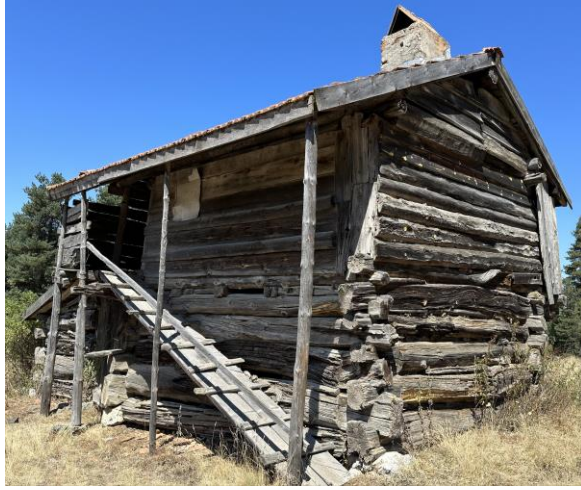
Şekil 4.80. Karaboğaz geçme yerlerinde yer alan taş temel.
