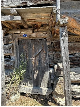
a) Fındıklı 2 nolu konut ahır dış kapısı
