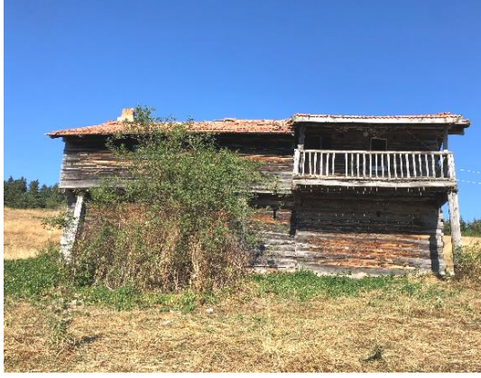
a) Batı cephesi
