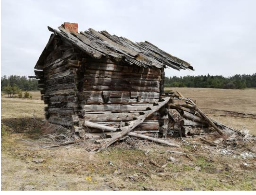
a) Gölcük yaylası 24 nolu konut çatısında kullanılan bedavra tahtaları.
