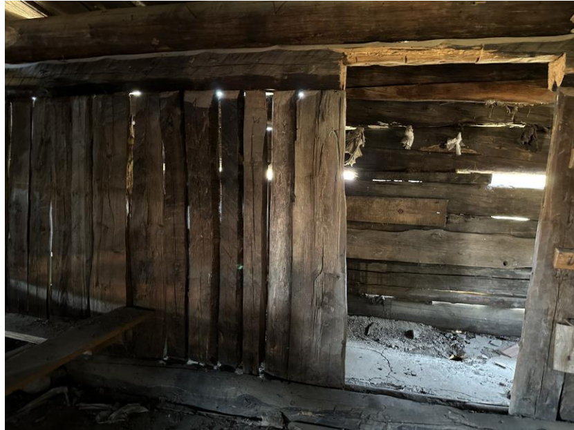
Şekil 4.68. Gölcük yaylası 20 nolu konut sütlük mekânını ayıran ahşap duvar.
