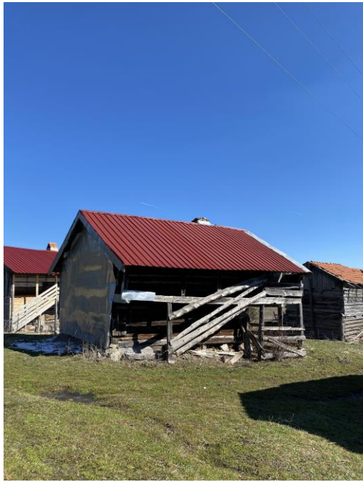
c) Ekinözü yaylası 3 nolu konut çatısında kullanılan oluklu sac.
