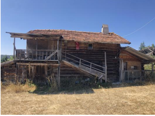
a)Çardak mekânına giriş
