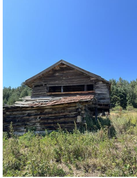
b) Çardak cepheden görünüşü
