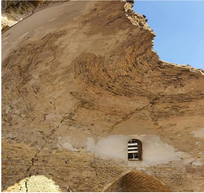
Fotograf 69: Paşa hamamı'nın durumu
