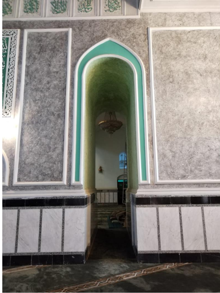
Fotograf 38: Genişletme çalışması için yeni açılan kemerler
