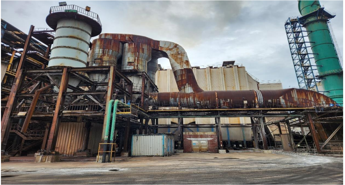
Şekil 3.14. Multi siklon toz toplama sistemi
