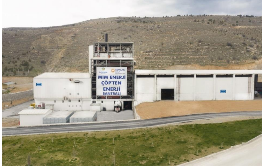
Şekil 4.4. Atık geri dönüşüm tesisi
