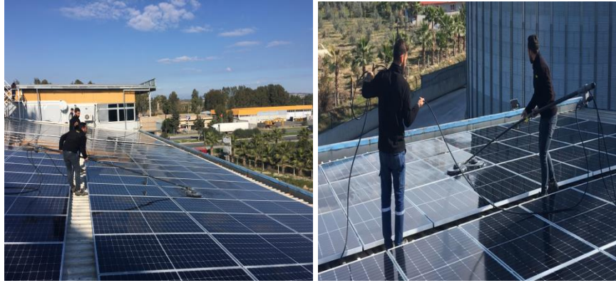
Şekil 4.30. Tesis panel yüzey temizliği.
