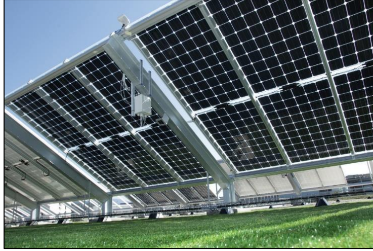
Şekil 5.17. Çift yüzlü (bifacial) güneş paneli [64].
