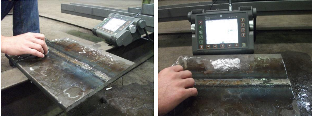
Şekil 3. Ultrasonik test kontrol işlemi.
