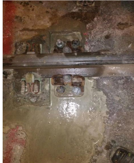
Şekil 8. Gizli boşluğa ilave selet montajı
