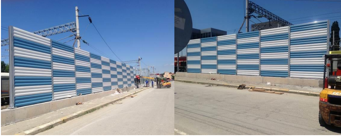
Şekil 6. Arifiye Tren İstasyonu alüminyum gürültü bariyeri uygulaması.
