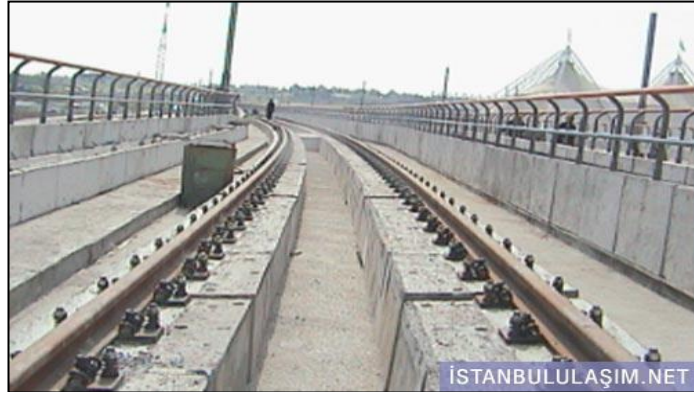
Şekil 2: Yenibosna – Havaalanı arası balastsız üstyapı (Metro İstanbul A.Ş.)
