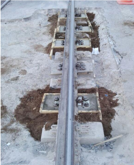
Şekil 8. Gizli boşluğa ilave selet montajı
