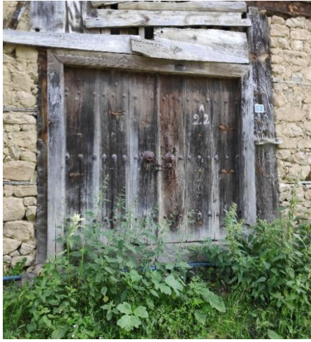
Şekil 4.50. Çift kanatlı ahşap kapı örneği (Dudan mahallesi Osman Gökler evi).
