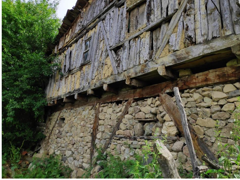
Şekil 4.28. Ahşap kaplama tahtaları örnekleri.
