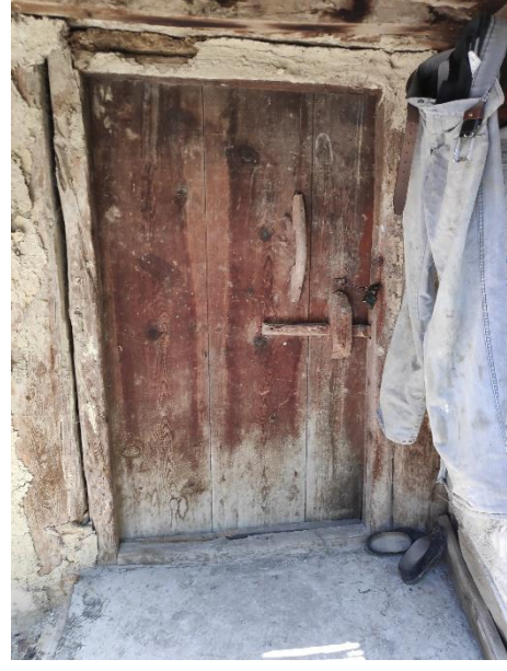
Şekil 4.52. Dudaş köyünde ahşap tek kanatlı konut dış kapı örnekleri.
