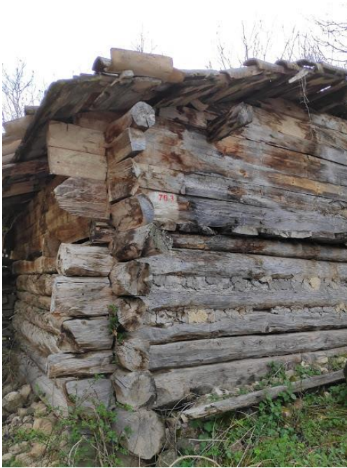
Şekil 4.17. Dudaş köyü samanlık yapılarında ahşap yığma duvar örnekleri.
