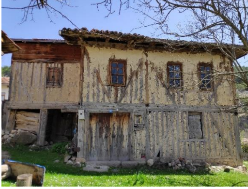
a) Karkas sistem geleneksel malzeme (Alizaim mahallesi)
