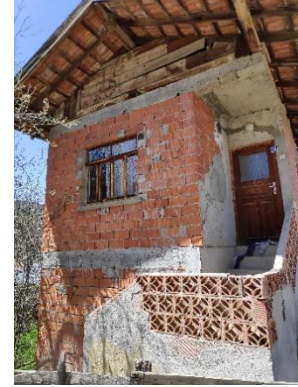
d) Yığma sistem modern malzeme (Yuvalar mahallesi)
