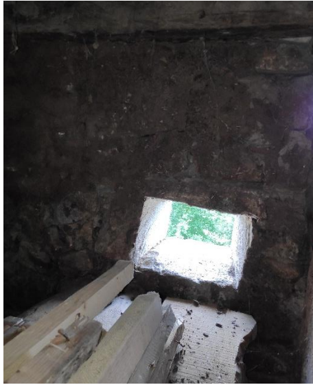
a) Temek penceresi yapı içerisinden
