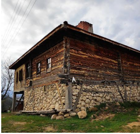
Şekil 2.9. Alizaim mahallesinde aktif olarak kullanılan köy konağı.
