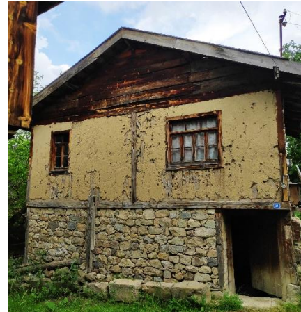
b) Beşik çatı örneği (Çataklı mahallesi)
