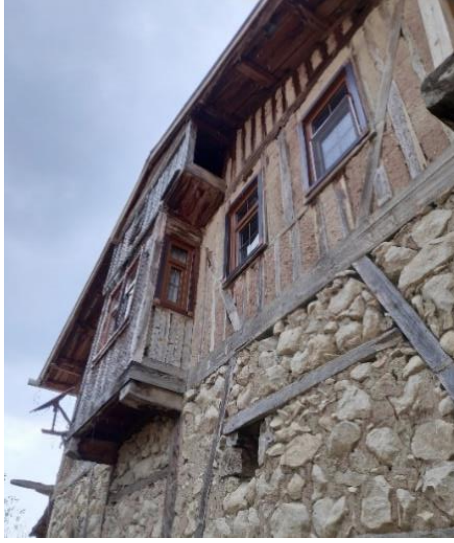
Şekil 4.36. Dudaş köyünde konsol kirişli çıkma örnekleri (Aliziam mahallesi).
