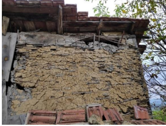
Şekil 4.21. Örgü dallar ile duvar oluşumu.
