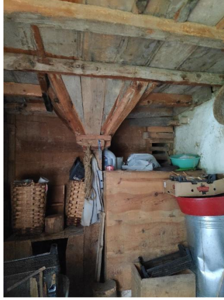
Şekil 4.63. Ocak kaidesinin farklı bir teknikle oluşturulması.
