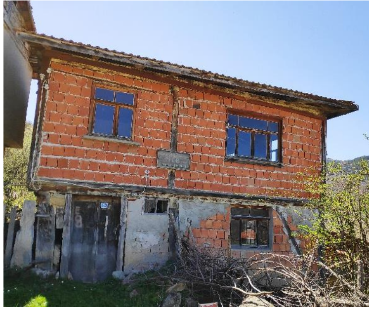
Şekil 2.11. Yuvalar mahallesinde bulunan ilkokul yapısı.
