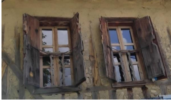
Şekil 4.59. Ahşap kapaklı ve parmaklıklı giyotin pencere örneği (Mıcık mahallesi).
