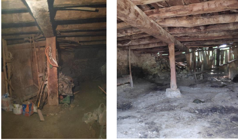
Şekil 4.9. Ahşap dikmelerin taş bloğa oturtulması.
