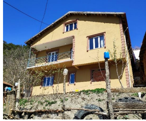
c) Üç katlı yapı örneği (Yukarı Kayalar mahallesi)
