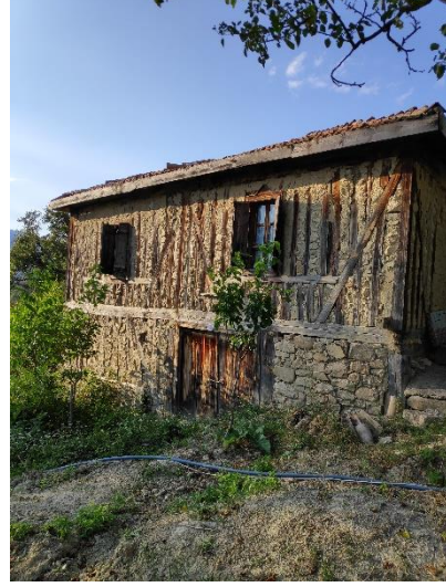
b) Orta durumda yapı örneği (Mıcık mahallesi)
