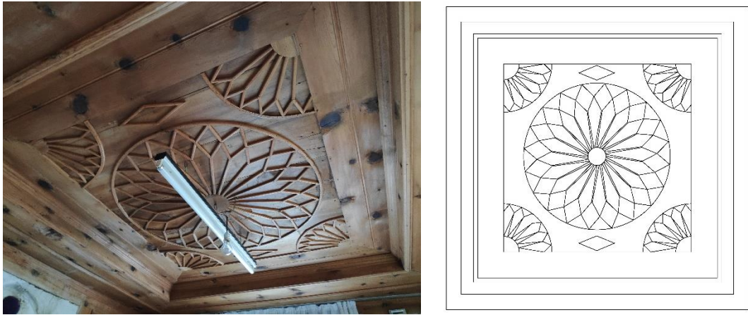
Şekil 4.31. İşlemeli tavan örneği (Çataklı mahallesi Halil Çelik evi).
