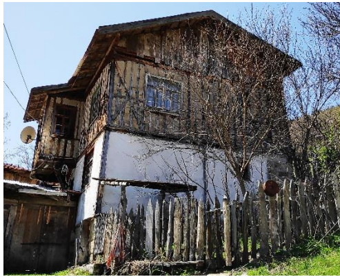
a) İyi durumda yapı örneği (Çataklı mahallesi)
