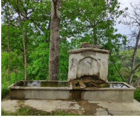
a) Çatakli mahallesi çeşmesi
