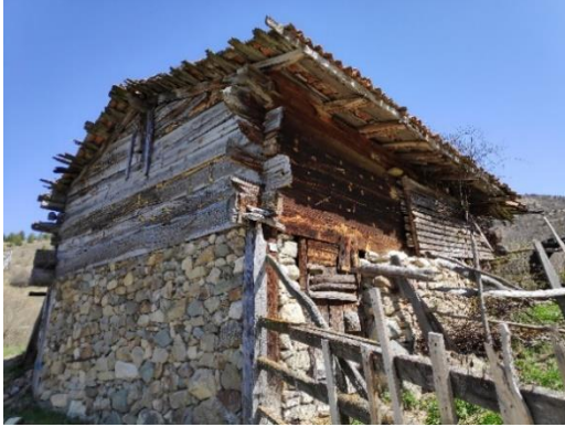
c) Yığma sistem geleneksel malzeme (Kızılelma mahallesi)
