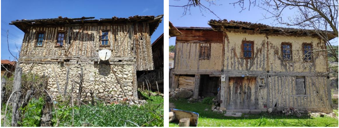
Şekil 4.19. Ahşap iskelet sistemli yapı örnekleri (Alizaim mahallesi).
