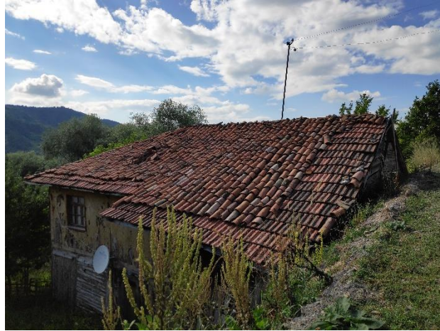
Şekil 4.47. Üç omuz çatı örneği (Dağdibi mahallesi).
