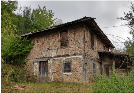
a) Dağdibi mahallesi harman tuğla kullanımı
