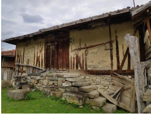
a) Tek katlı yapı örneği (Çay mahallesi)
