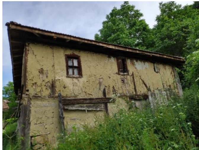
Şekil 4.12. Dudan mahallesi dolgu malzemesi olarak kerpiç kullanımı.
