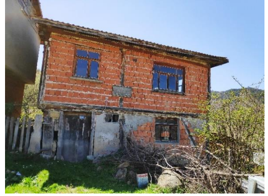
b) Karkas sistem modern malzeme (Yuvalar mahallesi)
