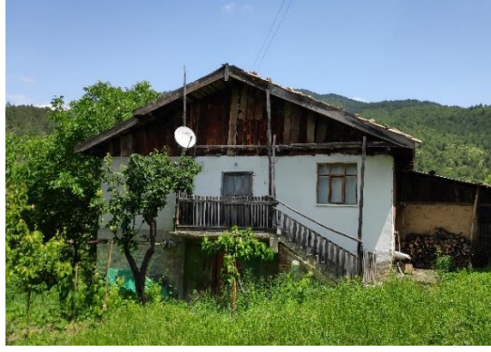
Şekil 2.23. Girişi dışarıdan merdivenle sağlanan konut örneği (Mıcık mahallesi Mustafa Ayvalık evi).
