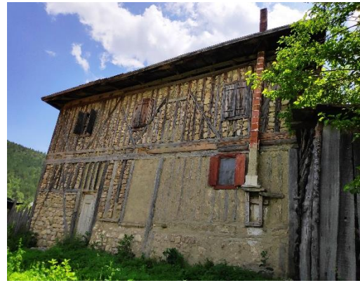
a) İyi durumda yapı örneği (Mıcık mahallesi)
