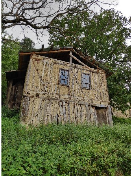
a) Beri Güvez mahallesi köy konağı
