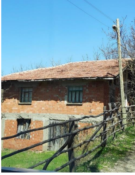
Şekil 4.14. Yeni yapıda modern tuğla malzeme kullanımı (Yuvalar mahallesi).
