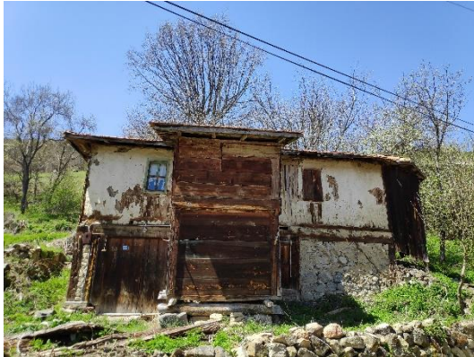
e) Karma sistem geleneksel malzeme (Çataklı mahallesi)
