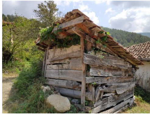
Şekil 2.32. Odunluk örneği (Alizaim mahallesi).
