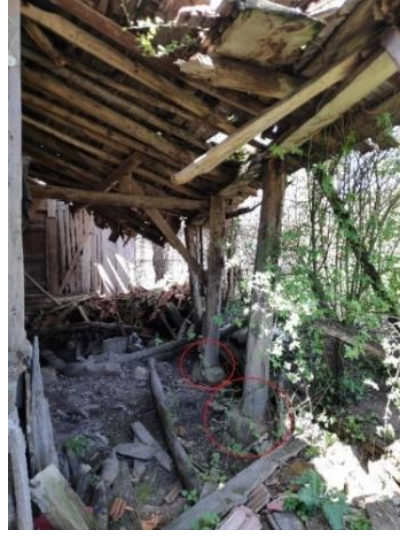
Şekil 4.22. Taş temelin üzerine oturtulmuş dikmeler.
