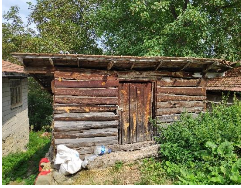
d) Sundurma çatı örneği (Çatakli mahallesi)
