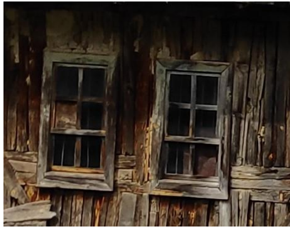
Şekil 4.58. Ahşap giyotin pencere örneği (Beri Güvez mahallesi).
