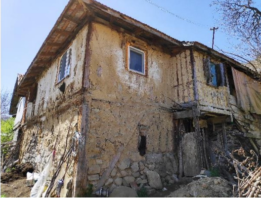
b) Az değişmiş yapı örneği (Çataklı mahallesi)
