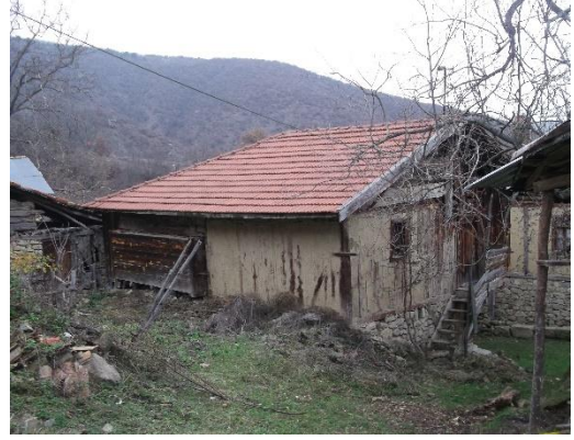
a) Tek katlı yapı örneği (Çatak mahallesi)
