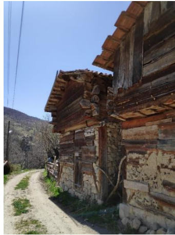
Şekil 2.28. Samanlıkta ahşap çantı örneği (Çataklı mahallesi).
