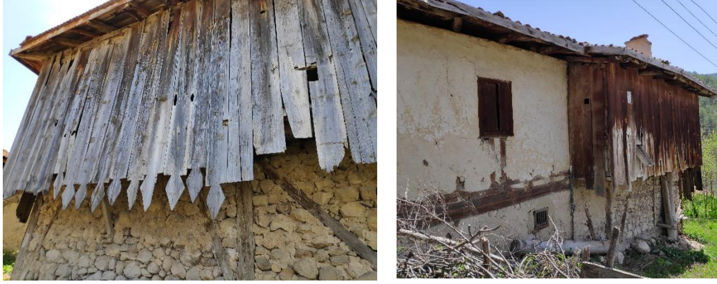
Şekil 4.40. Kaplama tahtalarıyla kapatılmış kapalı çıkma örnekleri.
