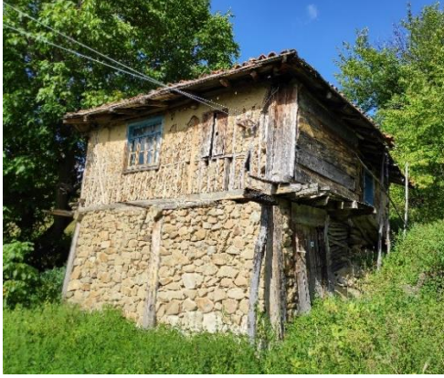
a) Dağdibi mahallesinde taş malzeme kullanımı
