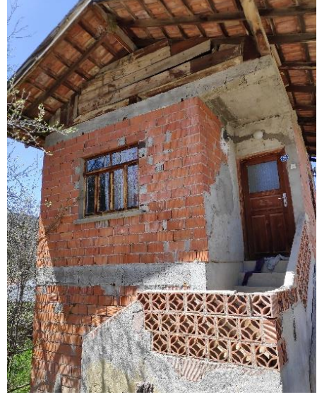
Şekil 4.14. Yeni yapıda modern tuğla malzeme kullanımı (Yuvalar mahallesi).
