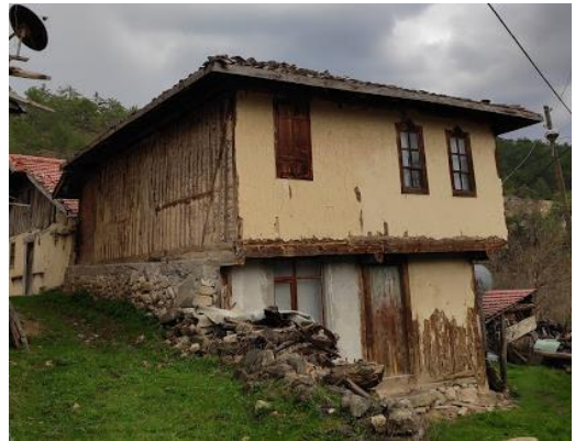
b) İki katlı yapı örneği (Alizaim mahallesi)
