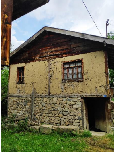
b) Orta durumda yapı örneği (Çataklı mahallesi)
