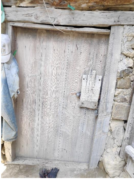
Şekil 4.52. Dudaş köyünde ahşap tek kanatlı konut dış kapı örnekleri.
