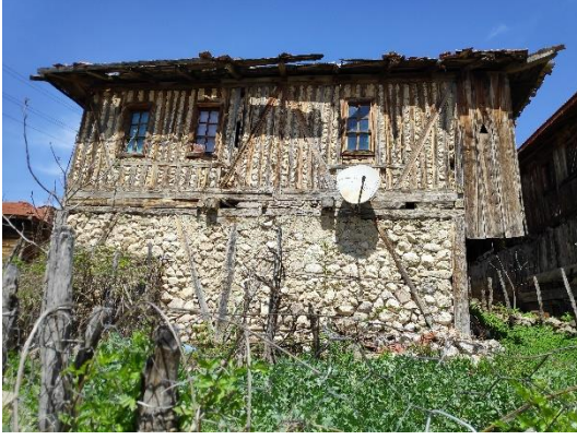
a) Özgün yapı örneği (Alizaim mahallesi)
