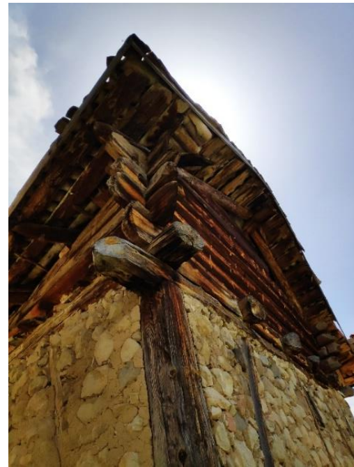
Şekil 4.17. Dudaş köyü samanlık yapılarında ahşap yığma duvar örnekleri.
