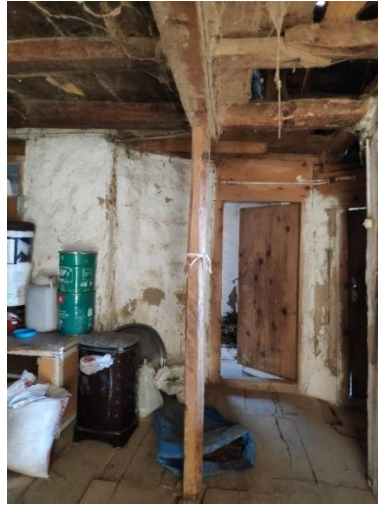
Şekil 4.23. Çardak mekanında başlıklı dikme kullanımı (Yukarı Kayalar mahallesi).
