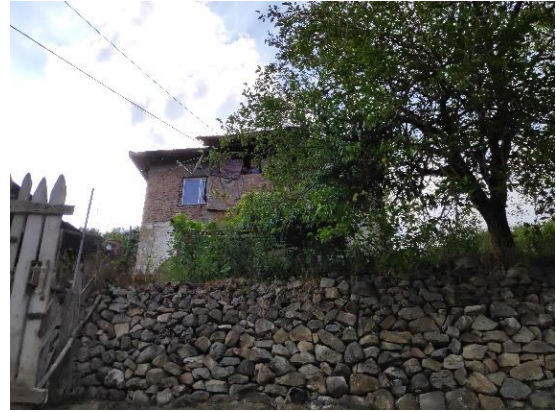
b) Moloz taşlar ile oluşturulmuş bahçe duvarı (Kızılelma mahallesi)
