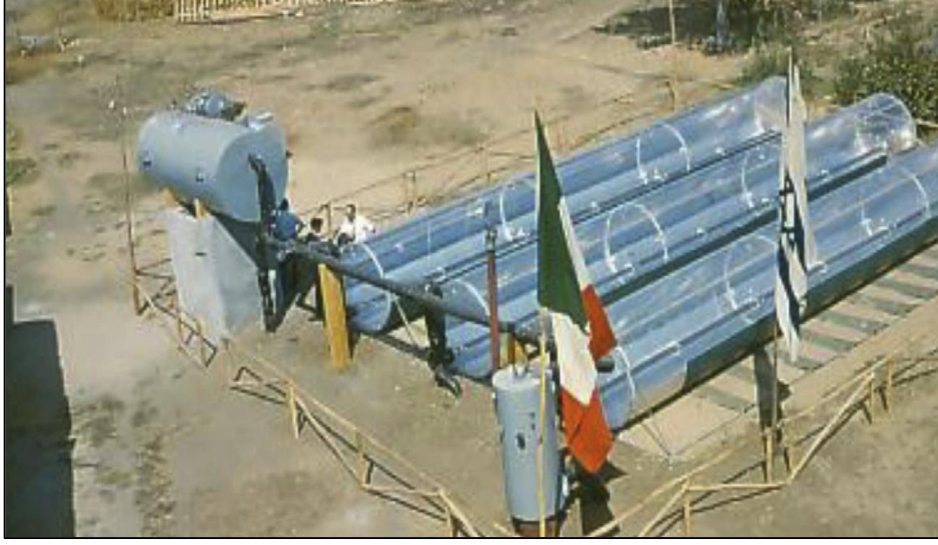
Şekil 4. 3 KW ORC Sistemi (1961) [8]
