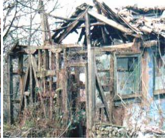
Şekil 15. Bakımsızlık ve terk edilmenin ahşap yapıdaki etkisi [7]
