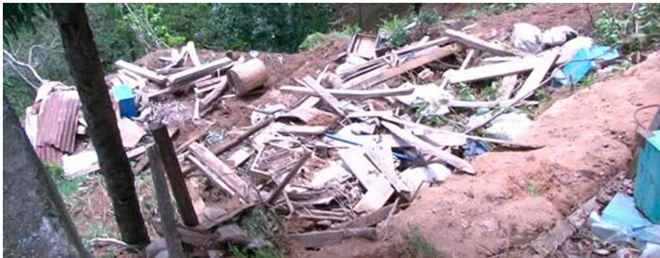
Şekil 8. Rize'de rüzgâr yükleri nedeniyle ahşap bir yapıda oluşan hasardan bir görünüm [10]
