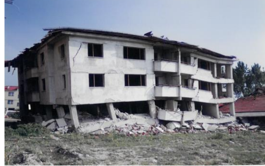
Şekil 4. Yumuşak kat veya zayıf zemin kat sonucu yıkılan binalar (1999 Marmara depremi, Adapazarı)
