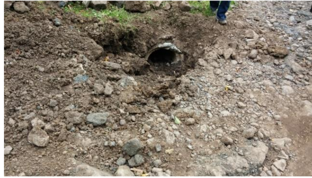
Şekil 2. Trabzon Of İlçesinde malzeme tarafından tıkanan büzün temizleme çalışmaları.
