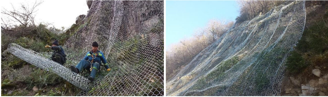
Şekil 6. Maçka Kanlıpelit Mahallesinde çelik ağ kaplama uygulaması.
