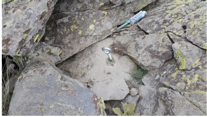
b) Gerdirme halatlarının bağlanacağı mapanın zemine ankrajı
