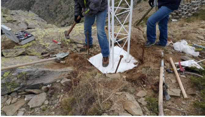
a) Taşıyıcı ana gövdenin kayaç zemine tespit edilmesi.
