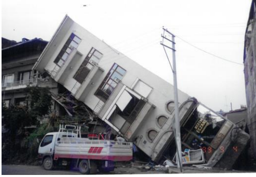
(a) Sıvılaşan zeminde yetersiz temel derinliğinden dolayı oluşan yapı hasarı
