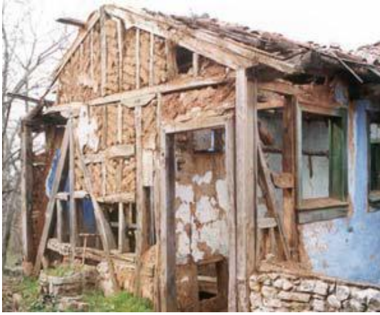
Şekil 15. Bakımsızlık ve terk edilmenin ahşap yapıdaki etkisi [7]
