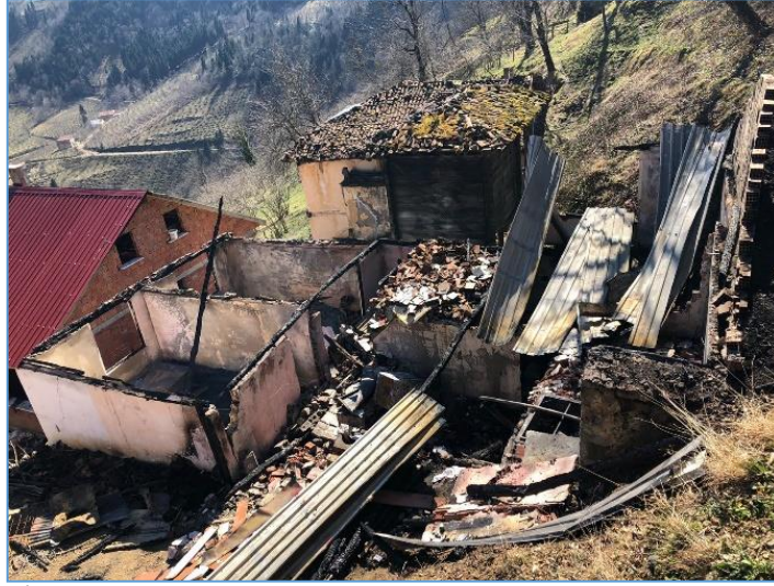
Şekil 1. Araklı İlçesi Turanlı Mahallesi’nde çıkan yangın sonucu kullanılmaz hale gelen konut.
