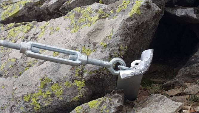
c) Gövdenin stabilitesini kuvvetlendirmek için kullanılan gerdirme halatlarının mapaya bağlanması
