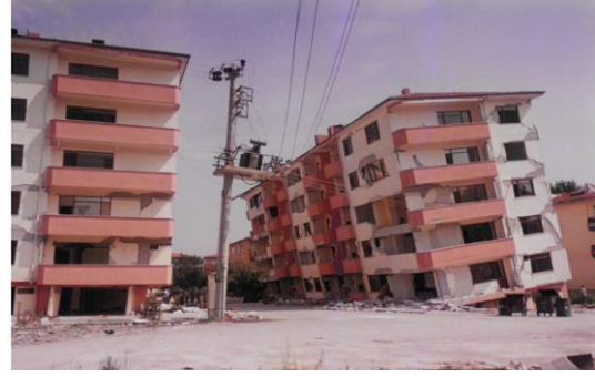
Şekil 5. Yumuşak kat veya zayıf zemin kat sonucu yıkılan binalar (1999 Marmara depremi, Adapazarı)
