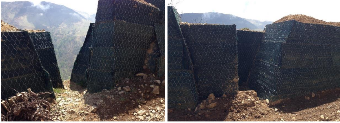
Şekil 8. Araklı ilçesi, Yeşilyurt Mahallesi'nde Toprakarme Gabion duvarın geçiş bölgeleri
