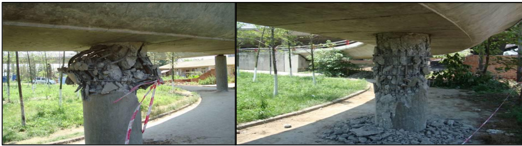
Figure 12. Huilan Köprüsü hasarlı P2 Ortaayağı ile hasarsız P3 Ortaayağı ve kesme hasarı oluşan ortaayak
