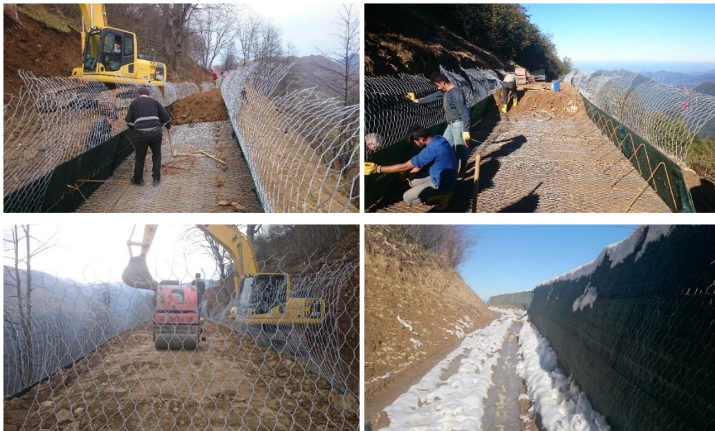
Şekil 7. Araklı ilçesi, Yeşilyurt Mahallesinde Toprakarme Gabion duvarı
