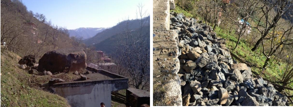
Şekil 9. Şalpazarı Çetrik Mahallesi'nde istifleme ve temizleme yöntemiyle kaya ıslahı
