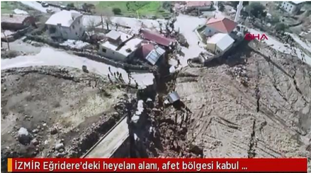
Şekil 6. İzmir ili Bornova ilçesi Eğridere Mahallesi'nde heyelan sonucu oluşan afet durumu [9].
