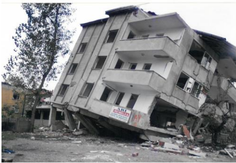
Şekil 4. Yumuşak kat veya zayıf zemin kat sonucu yıkılan binalar (1999 Marmara depremi, Adapazarı)
