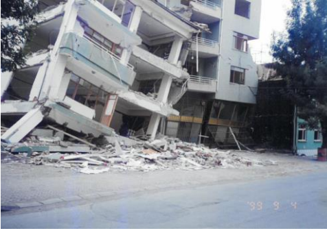
Şekil 5. Yumuşak kat veya zayıf zemin kat sonucu yıkılan binalar (1999 Marmara depremi, Adapazarı)
