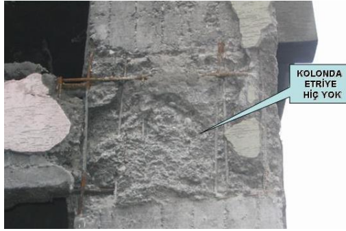
Şekil 6. Kolon-kiriş bileşim yerinde yetersiz etriye olması
