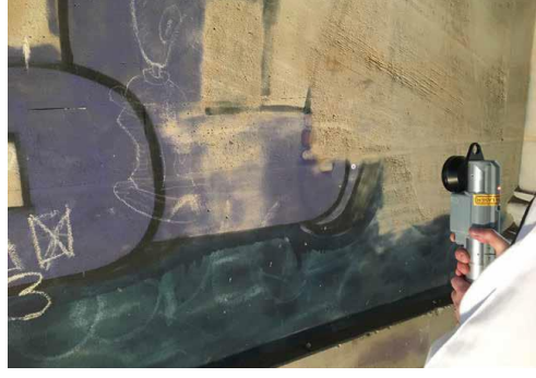
Şekil 2.38. Lazer yöntemi ile spreyci boyay temizliđi (Zanini vd, 2019).
