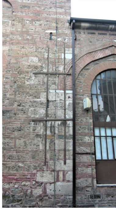
Şekil 5.16. Üftade Camii beden duvarı güçlendirme demirleri.
