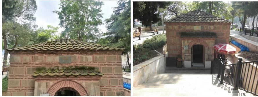
Şekil 5.26. Okçubaba Türbesi üzerindeki bitki oluşumlarının çeşitli mevsimlerdeki görünümleri. a) Bahar mevsimindeki yosunlaşma görünümü. b) Yaz ve sonbahar mevsiminde yosunlaşma görünümü.
