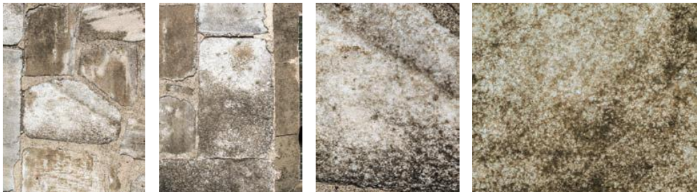
Şekil 2.17. Şekerlenme örnekleri (Kudde vd, 2016).
