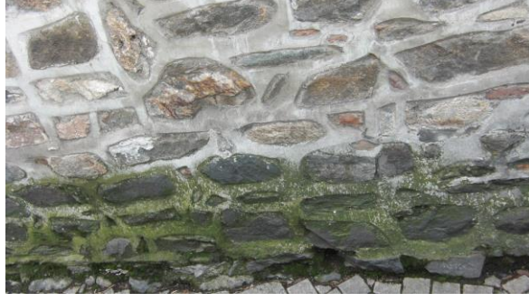
Şekil 5.19. Duvar eteklerinde meydana gelen yosunlanma.
