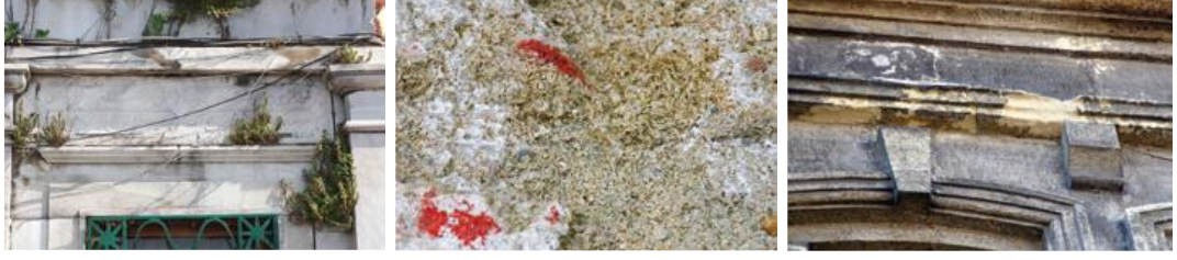
Şekil 2.12. İklimsel nedenler bağlı bitki, tuzlanma ve siyah kabuk oluşumları (Ersen, 2013).
