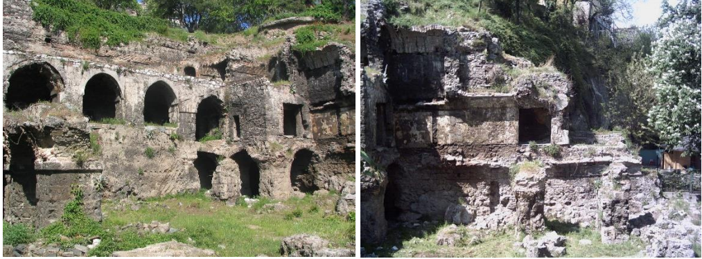
Şekil 4.31. Balibey Han restorasyon öncesi (Piray Mimarlık arşivi).
