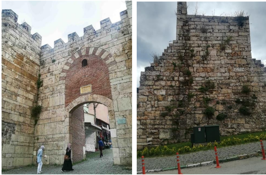
Şekil 5.6. Saltanat Kapı üzerindeki kararmalar ve bitki oluşumları.
