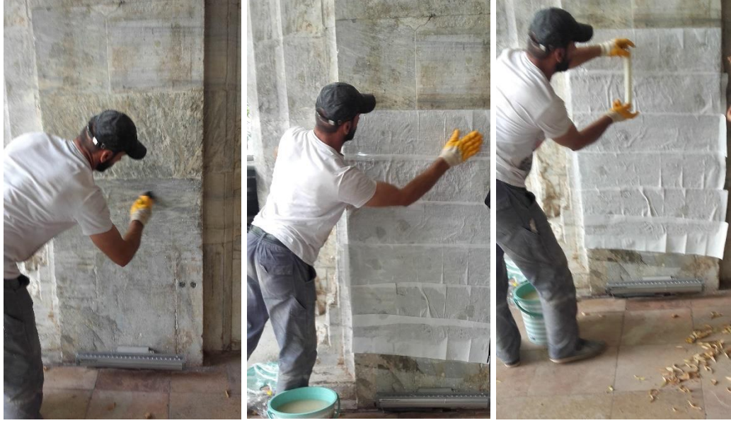
Şekil 2.32. Mermer yüzeyde AB 57 kimyasal temizlik uygulaması : Bursa Yıldırım Bayezid Camii (Analiz Restorasyon Mimarlık arşivi).
