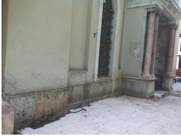
Şekil 4.9. Kuzey cephesinin cephe temizlik uygulamasından önceki durumu, (BVBM fotoğraf arşivi).
