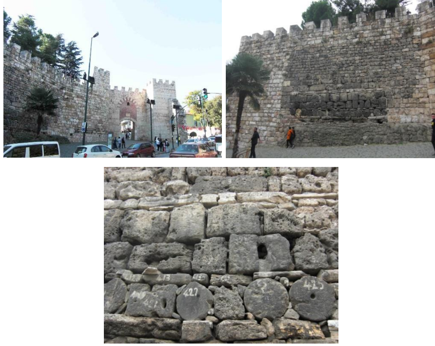
Şekil 5.5. Bazı kirliliklerin gözlemlendiği Saltanat Kapı'ya uzanan sur duvarı ve üzerindeki spoliyen malzemeler.
