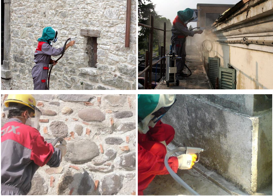
Şekil 2.28. Mikro kumlama uygulamaları (İnternet, 8).
