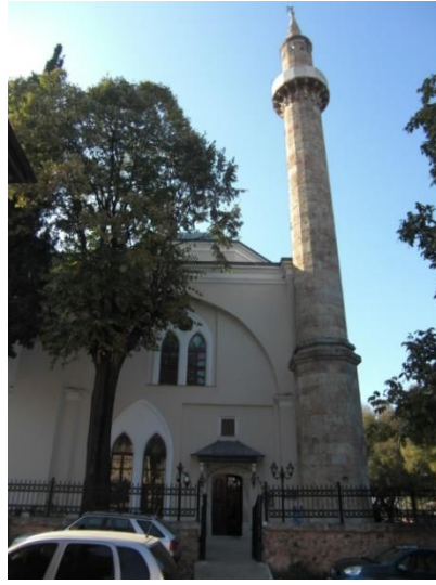
Şekil 4.5. Şahadet Camii minaresi.
