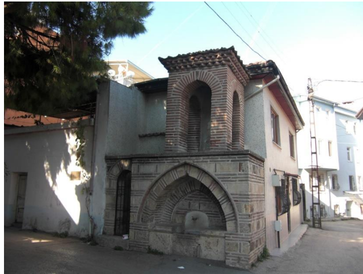
Şekil 4.14. Veled-i Yaniç Camii minare ve çeşmesi.
