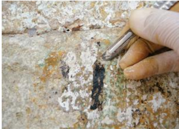
Şekil 2.25. Bistüri ile mekanik temizlik uygulaması (Ersen, 2013).
