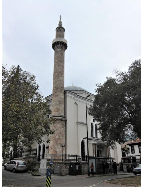
Şekil 4.3. Şehadet Camii genel görünümü.
