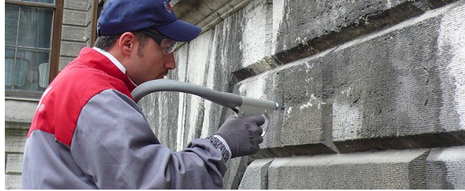
Şekil 2.30. Dolmabahçe Sarayı, küfeki taşı üzerinde mikro kumlama uygulaması (İnternet, 10).
