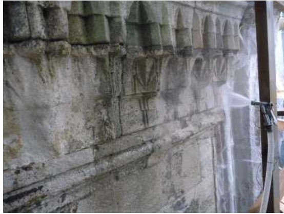
Şekil 2.35. Atomize su ile temizlik uygulaması (Anonim, 2015).
