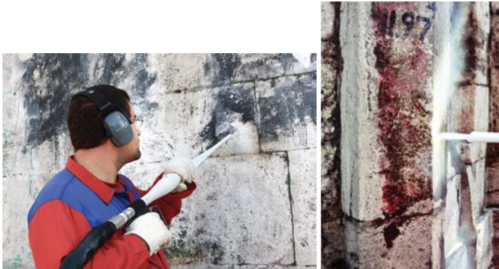
Şekil 2.36. Kuru buz yöntemi ile temizlik uygulaması (Ersen, 2013).
