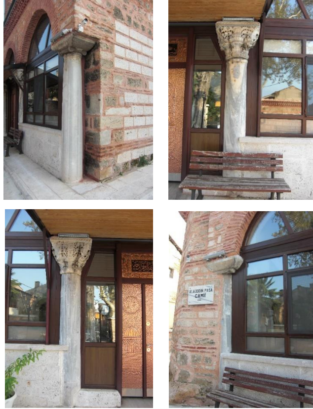
Şekil 4.19. Alaaddin Camii son cemaat revağındaki devşirme sütunlar.
