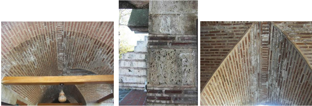
Şekil 5.32. Cephe, kemer ve tonoz üzerinde tuzlanma oluşumları.
