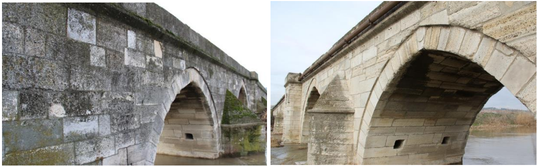
Şekil 2.9. Bir ince yonu taş duvar örgüsü: Lüleburgaz Sokullu Mehmed Paşa Köprüsü (İnternet, 3).
