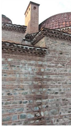
Şekil 5.35. Akıntı nedeniyle meydana gelen kararma ve renk değişimleri.
