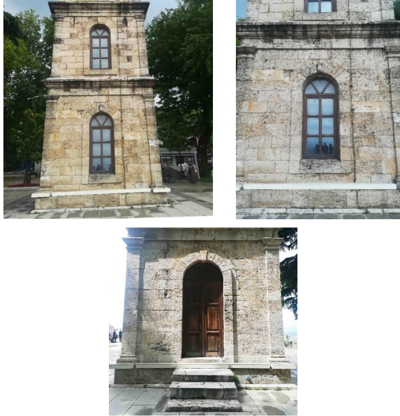
Şekil 4.41. Cephe yüzeyindeki kirlilikler.
