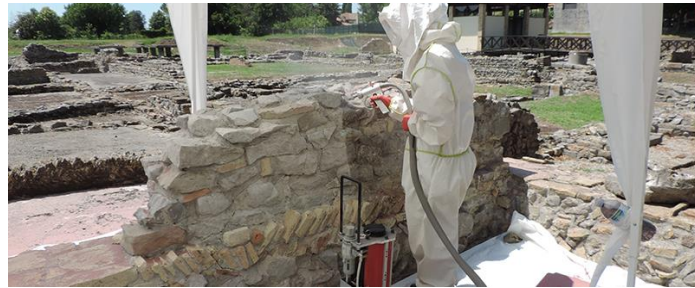
Şekil 2.31. Aquileila Forum Kalıntılarında mikro kumlama yöntemi ile kir ve biyolojik oluşumların temizliği (İnternet, 11).
