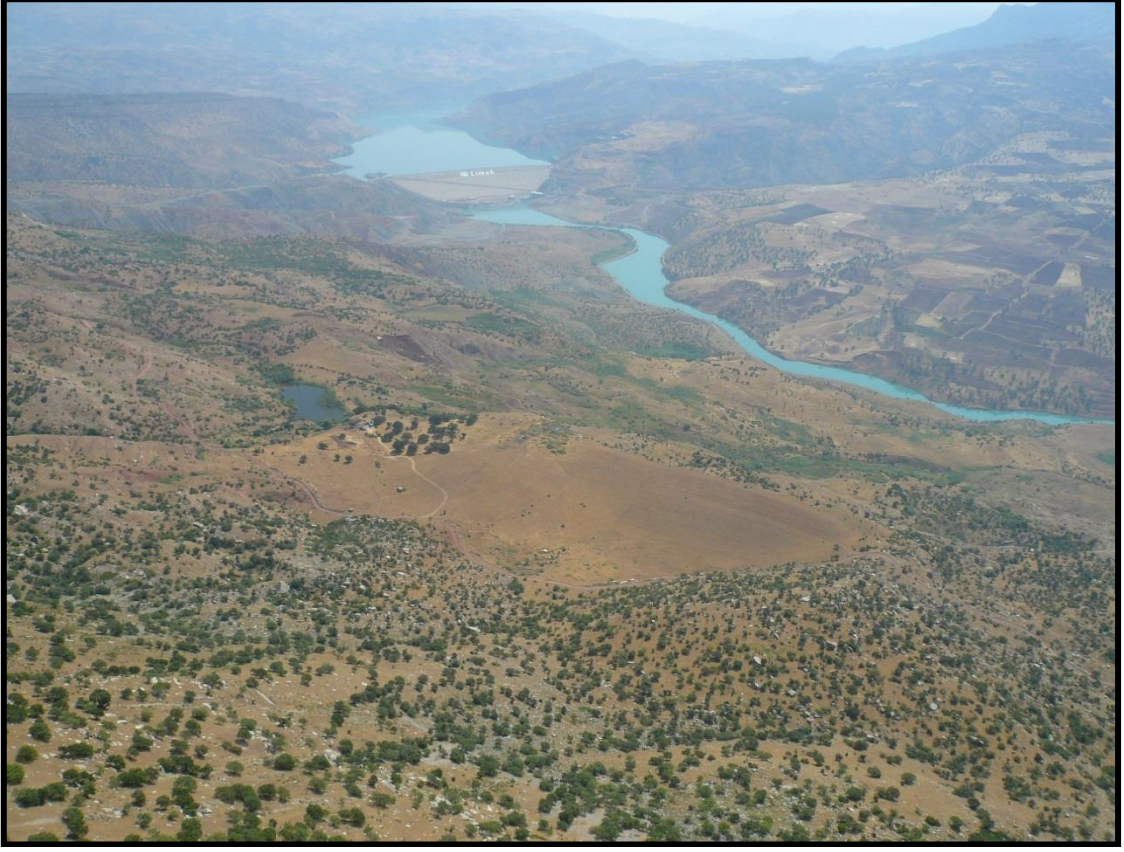
Fotoğraf 7: Tillo İlçesinde Bulunan Alkumru Barajından Bir Görünüm.
