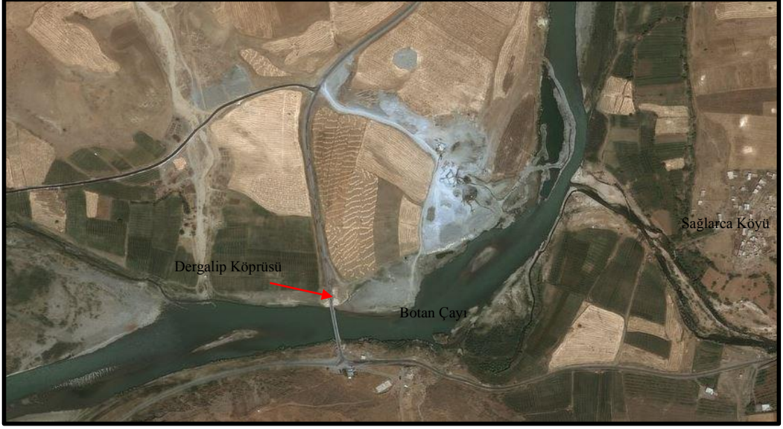
Fotoğraf 36: Siirt Merkez İlçesinde Dergalip Köprüsüne Yakın Bir Kum İşletme Merkezinin Uydur Görünümü (Earth Explorer).
