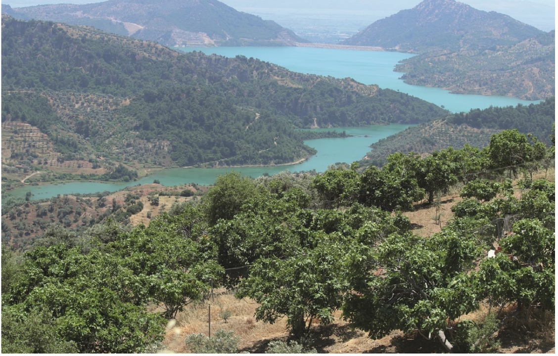
Fotoğraf 4: İncirliova İdari Sınırları İçinde Yer Alan İkizdere Barajı
