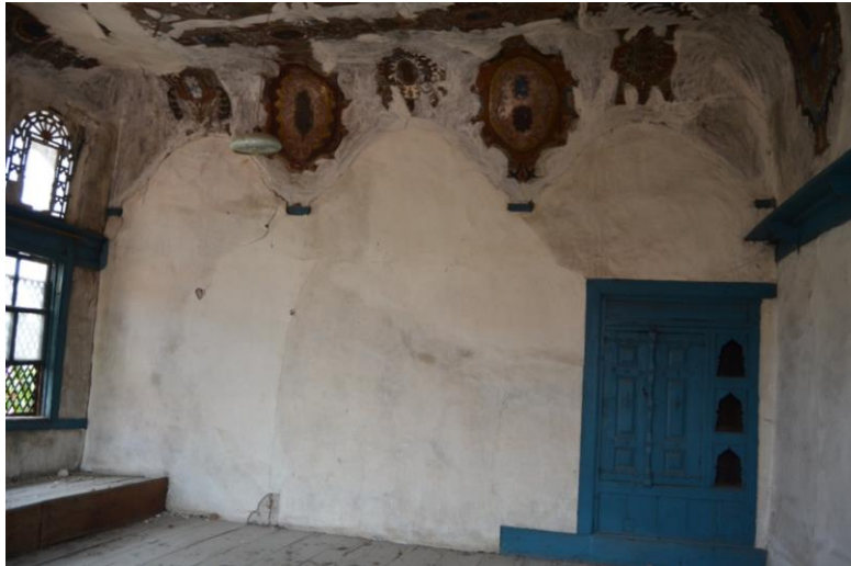
Resim 176. Özdarendeliler Konağı, Odanın Güney Duvarı
