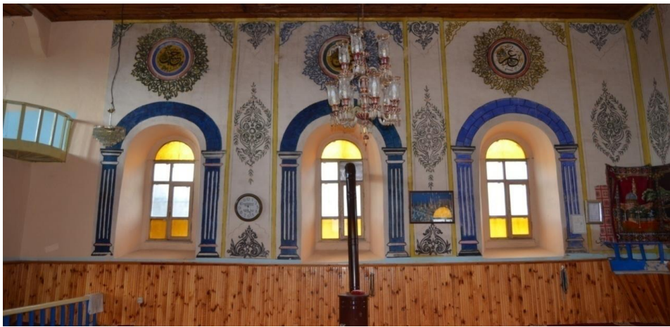
Resim 56. Çay Köyü Camii, Harimin Doğu Duvarı
