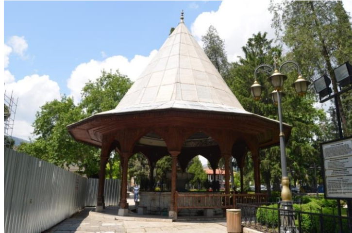
Resim 89. II. Beyazıt Külliyesi Camii Şadırvanı, Şadırvanın Genel Görünümü
