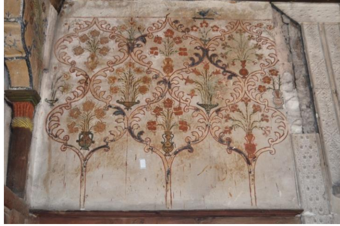
Resim 184. Özdarendeliler Konağı, Başodanın Batı Duvarındaki Bezemeler
