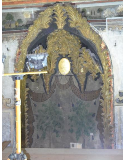
Resim 199. II. Beyazıt Külliyesi Muvakkithanesi, Batı Duvar Ortasındaki Niş
