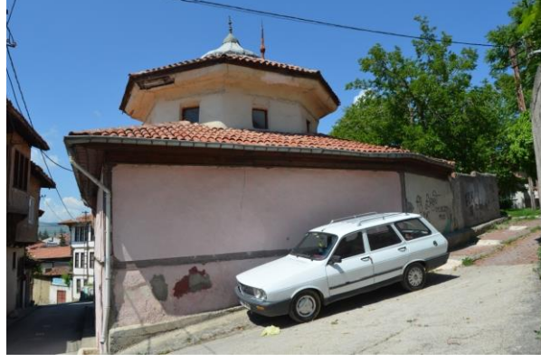
Resim 216. Musa Fakih Türbesi, Doğu Cephesi
