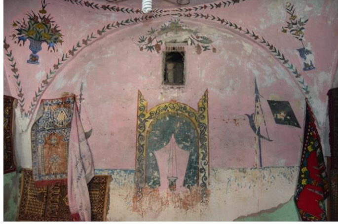
Resim 159. Hacı Nazır Baba Türbesi, Türbenin Güney Duvarı
