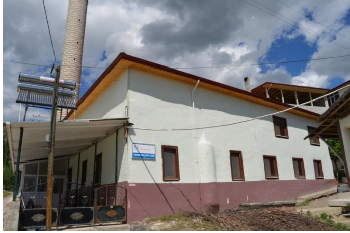
Resim 208. Salkımören Köyü Camii, Caminin Güneybatı Yönü
