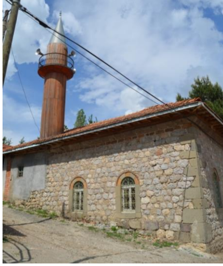
Resim 58. Kösele Köyü Camii, Caminin Batı Cephesi
