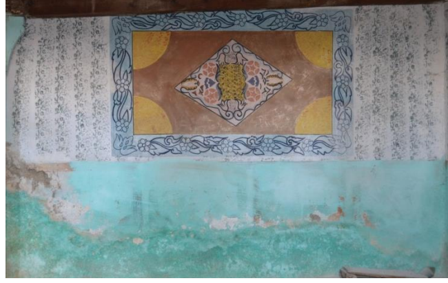
Resim 18. Kaleköyü Camii, Kuzey Duvarın Mahfil Altı
