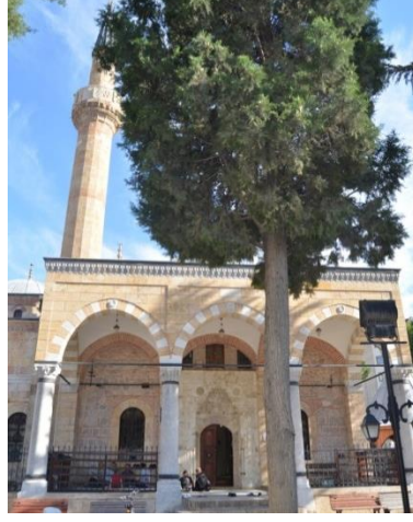
Resim 84. Azeriler Camii, Caminin Kuzey Cephesi
