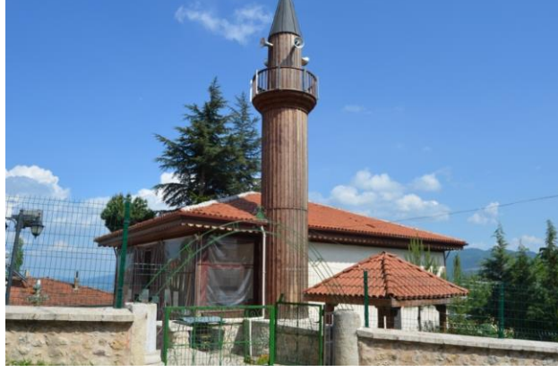
Resim 36. Aşağı Baraklı Camii, Batı Cephesi
