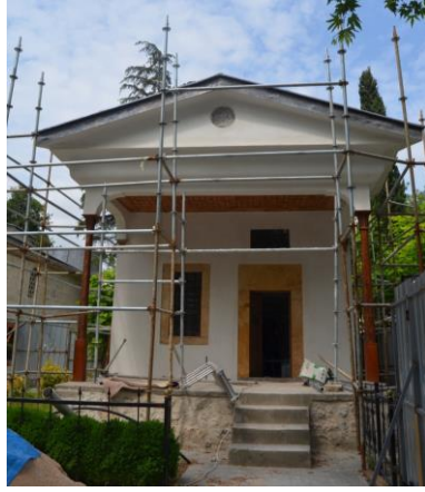
Resim 190. II. Beyazıt Külliyesi Muvakkithanesi, Doğu Cephesi
