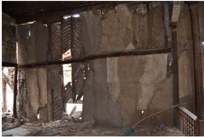
Resim 182. Özdarendeliler Konağı, Başodanın Kuzey Duvarı
