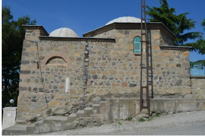
Resim 136. Piri Baba Türbesi, Doğu Cephesi
