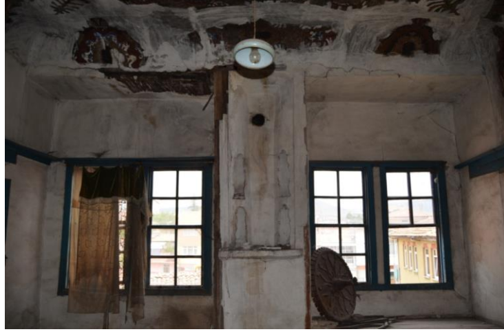
Resim 180. Özdarendeliler Konağı, Odanın Kuzey Duvarı
