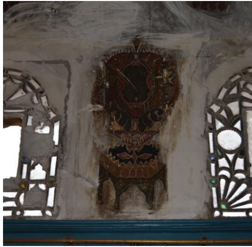
Resim 179. Özdarendeliler Konađı, Dođu Duvarındaki Sehpa Tasviri
