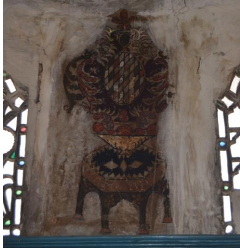
Resim 178. Özdarendeliler Konađı, Dođu Duvarındaki Sehpa Tasviri
