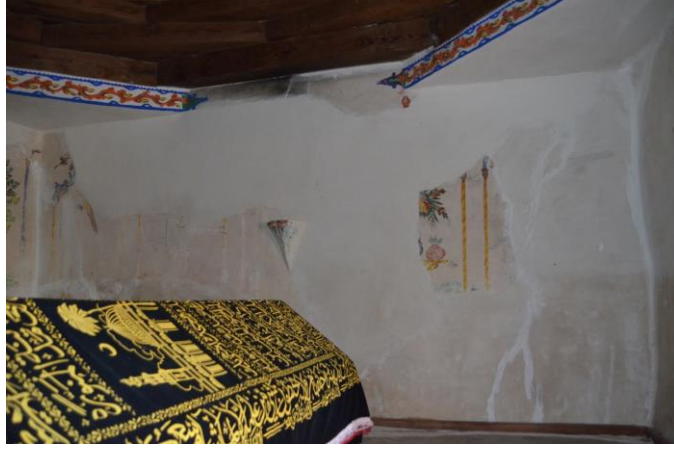
Resim 235. Şeyh Eylük Türbesi, Doğu Duvarın Günümüz Görüntüsü
