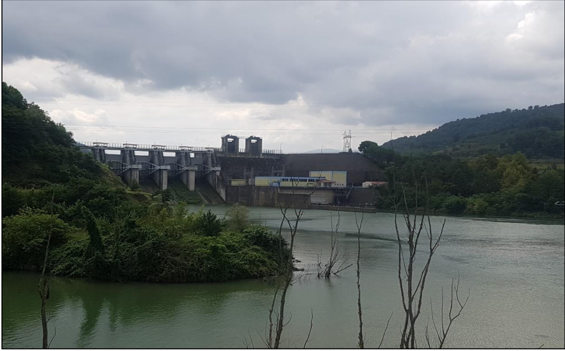
Fotoğraf 3. Suat Uğurlu Hidroelektrik Santrali
