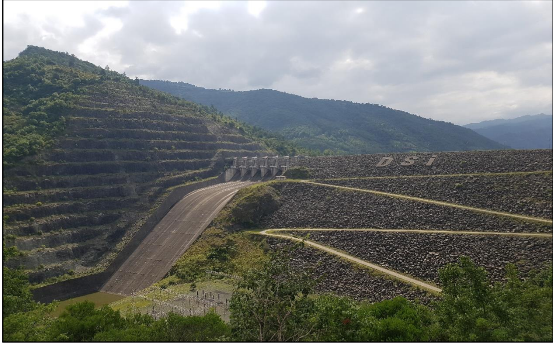
Fotoğraf 4. Hasan Uğurlu hidroelektrik santrali
