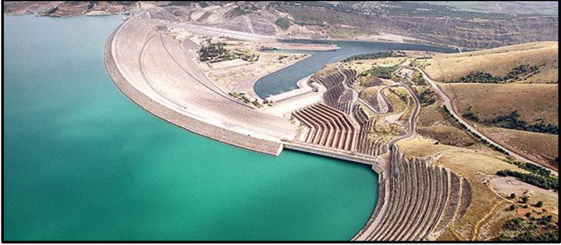
Resim 3. GAP Projesi kapsamında yapılan baraj
