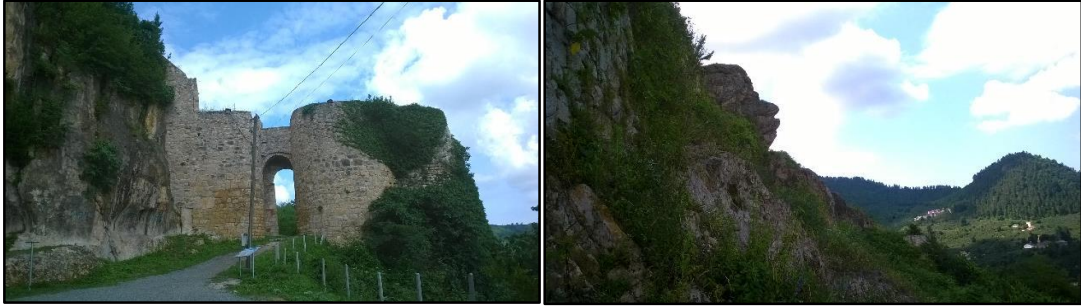
Fotoğraf 74. Ünye Kalesi Giriş Kısmı ve Ünye Kalesi'nin İç Kısmında Yer Alan İnsan Figürü
