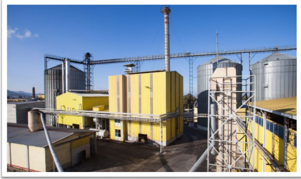
Fotoğraf 16. Ayçiçekyağı Üreten Fabrikanın Rafine ve Dolun Tesisi
