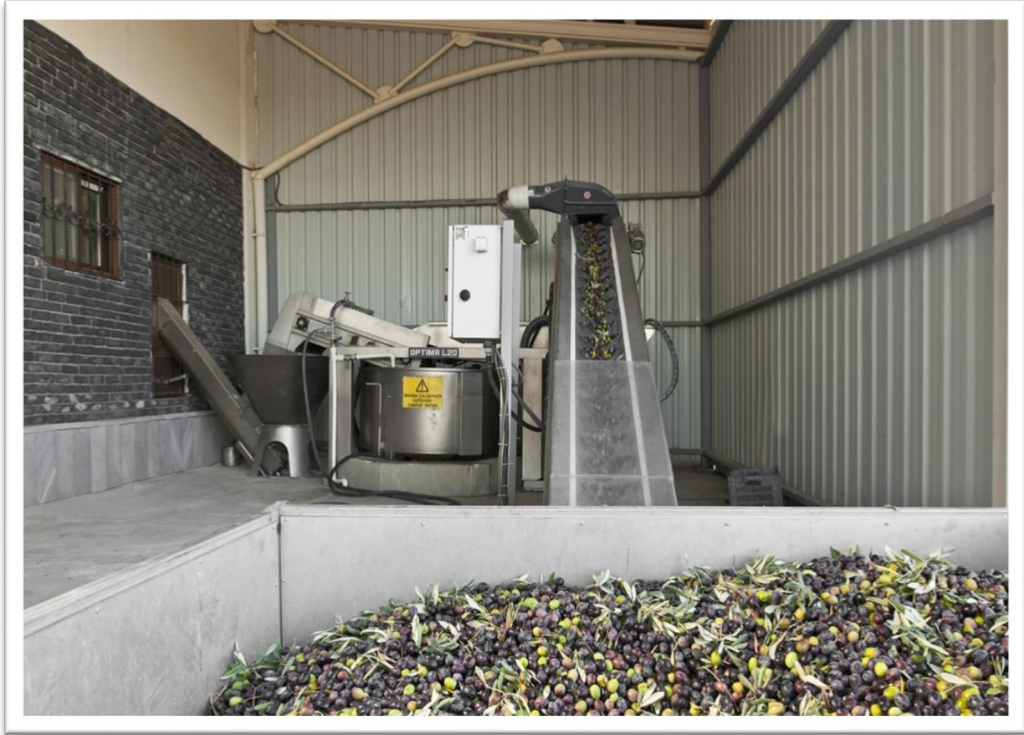
Fotoğraf 1. Zeytin Yıkama ve Temizleme Ünitesi
