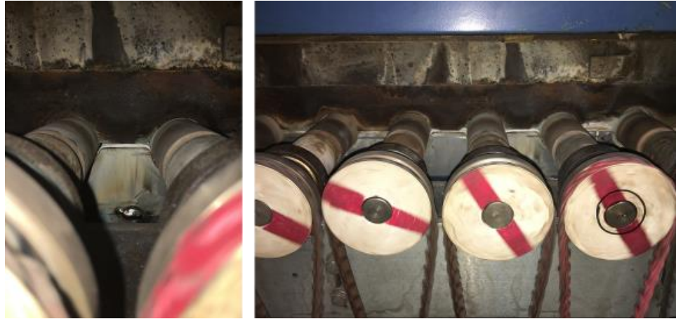
řekil 7.4 Temper yalıtım sonrası fotoęrafları.
