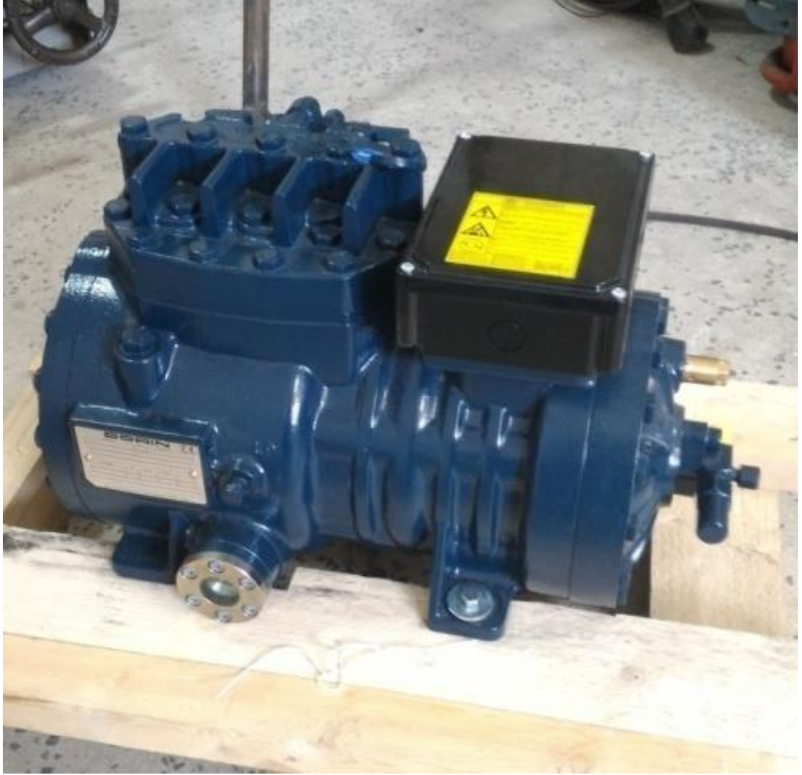
Şekil 5.4. CO 2 'li sistemde kullanılan kompresör.
