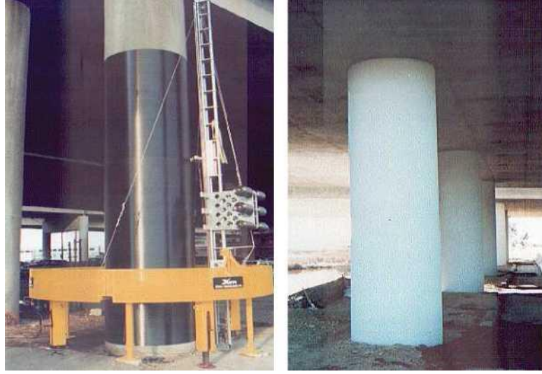
Şekil 4.2. Karbon Elyaf Kolon sargısının uygulanması ve tamamlanmış karbon elyaf kolon sargısı [21].
