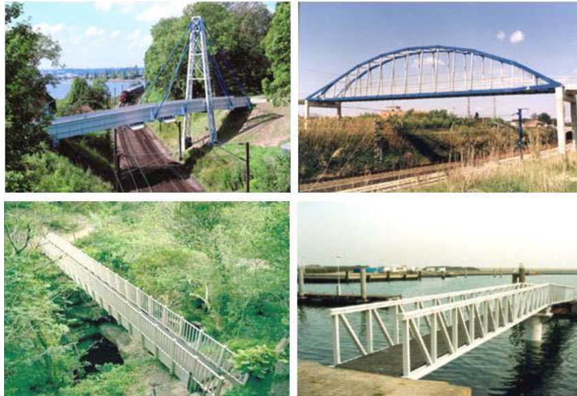
Şekil 1.2. CTP profillerle üretilmiş hafif yapı örnekleri [15].
