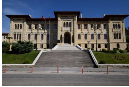
Foto. 16 Kastamonu Hükümet Konağı, 1901 (Kişisel Arşiv)
