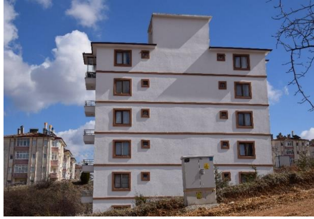
Foto. 99 Egemen Apartman, Arka Cephe, 2018 (Kişisel Arşiv)
