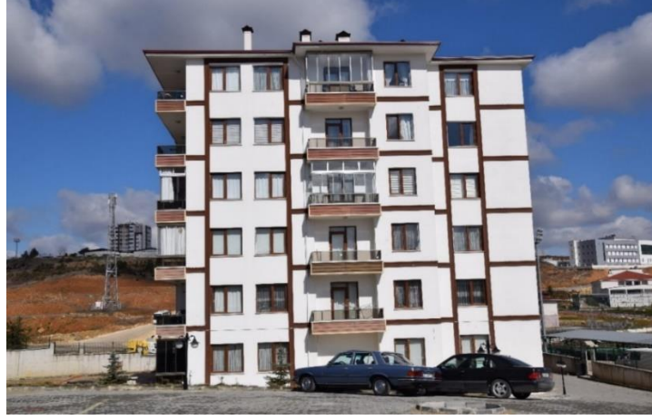
Foto. 92 Kuzeykent Mahallesi, Gölpark Sitesi, 2015-2017, Detay (Kişisel Arşiv)
