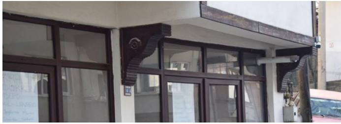
Foto. 50 Nazım Bey Apartmanı, Çıkmanın Altındaki Destek Elemanları (Kişisel Arşiv)
