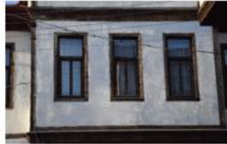
Kırkcesme Mahallesi, Kırkcesme Caddesi, No:11
