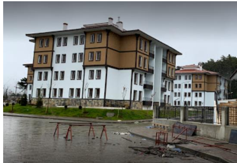
Foto. 94 İhsangazi İlçesi TOKİ Konutları, Detay (2016-2017)
