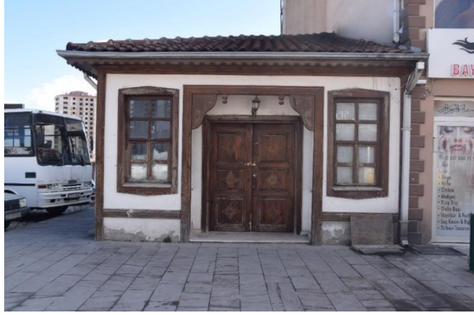
Foto. 111 Kuzeykent Mahallesi, Kazım Karabekir Caddesi, Ufo İş Merkezi (Kişisel Arşiv)
