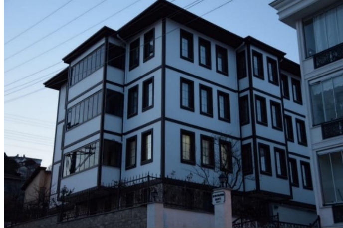
Foto. 102 Safran Apartmanı, Arka Cephe (Kişisel Arşiv)
