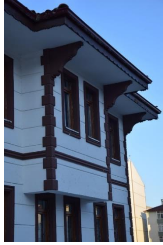
Foto. 68 Yapının Çatısını Destekleyen Destekler ve Çıkma, 2017 (Kişisel Arşiv)
