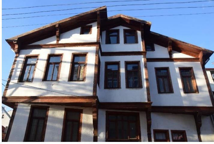
Foto. 9 Çatı Eğimi Kısımda Yapılan Çatı Odası, Cebrail Mahallesi, Kırkçeşme Caddesi, No: 67, 19.yüzyıl (Kişisel Arşiv)
