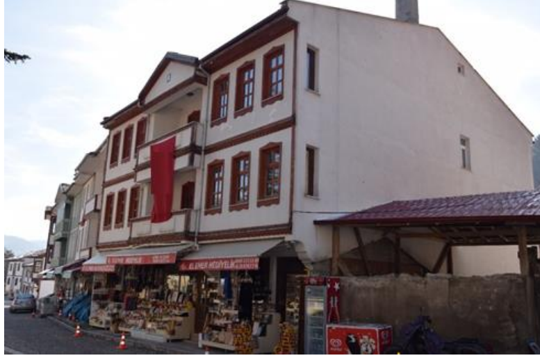
Foto. 25 Hatice Topaloğlu Binası, Sade Bırakılan Cephesi, 2000 (Kişisel Arşiv)
