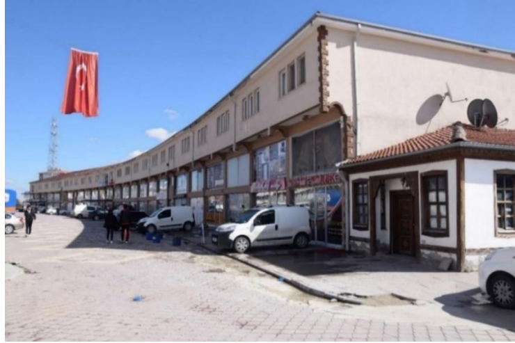
Foto. 110 Kuzeykent Mahallesi, Kazım Karabekir Caddesi, Ufo İş Merkezi, 2011 (Kişisel Arşiv)
