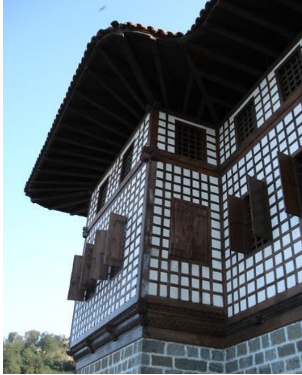
Şekil 3.36. Sıvalı göz dolma duvar örneği (Güneş, 2014).
