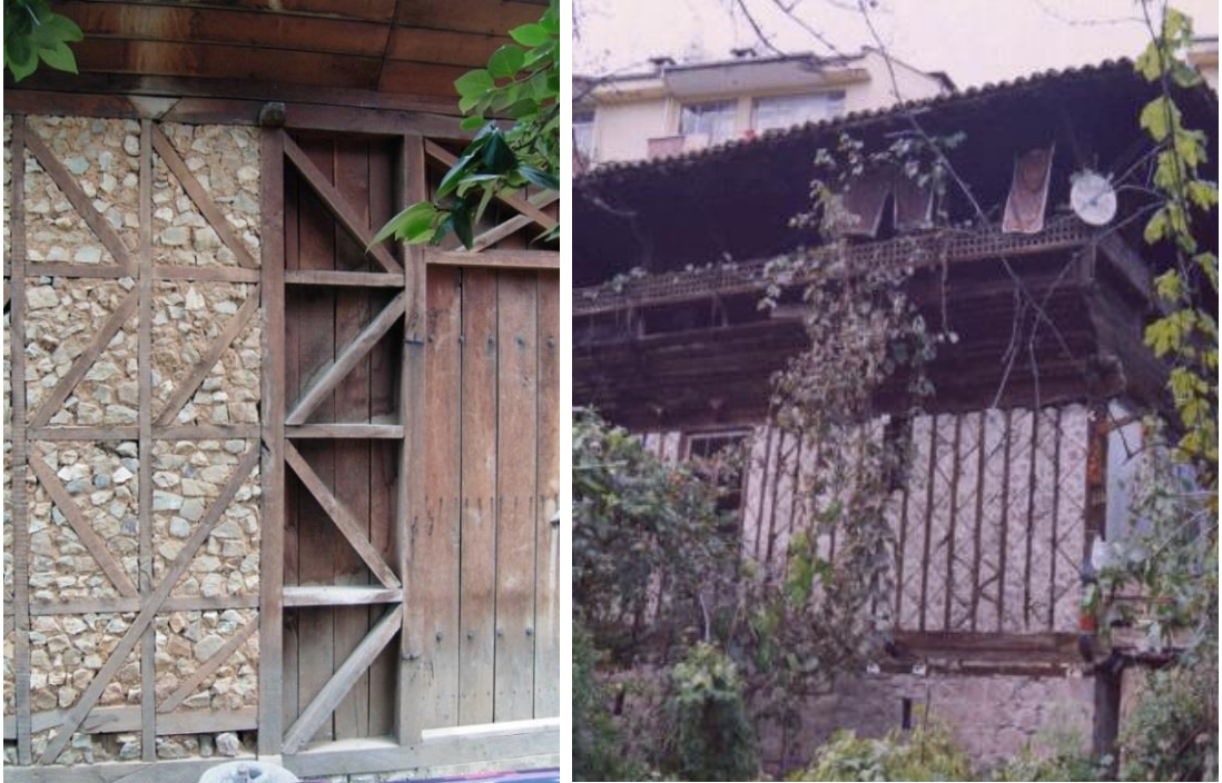
Şekil 3.28. Ahşap yapılarda muska dolma duvar örneği (Güneş, 2014).
