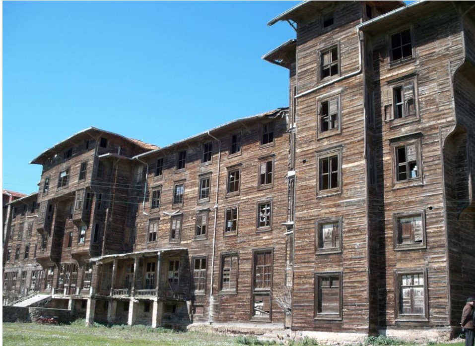
Şekil 3.18. Yalı baskı tekniğiyle yapılmış ahşap yapı örneği (Güneş, 2014).
