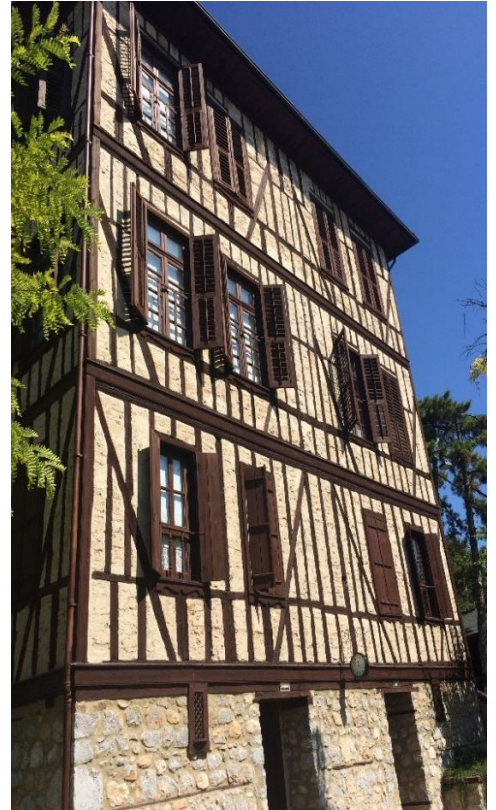
d) sağ cephe
