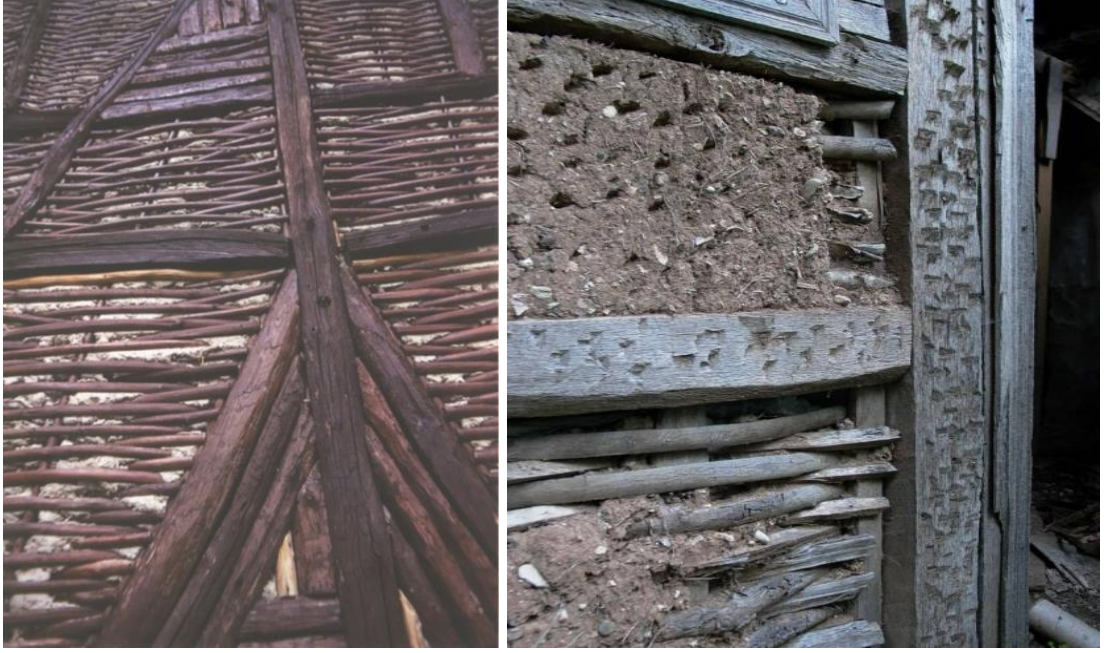
Şekil 3.21. Çöten duvar dalların aralarının sıvanması örneği (Güneş, 2014).
