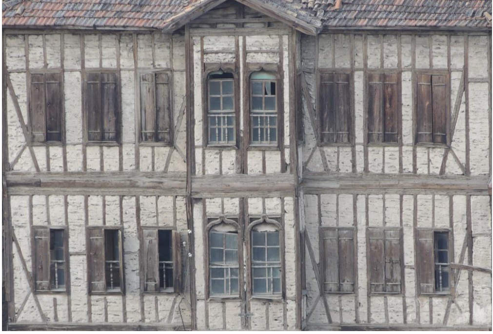
Şekil 3.24. Hımiş duvarlı ahşap yapı örneği (Güneş, 2014).
