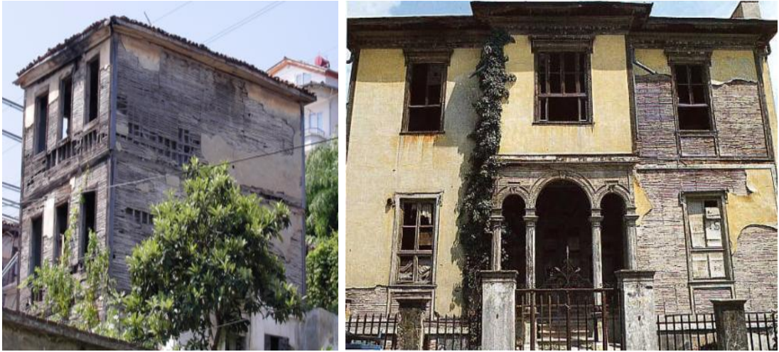
Şekil 3.16. Bağdadi tekniğiyle yapılmış ahşap yapı örnekleri (Güney, 2016).
