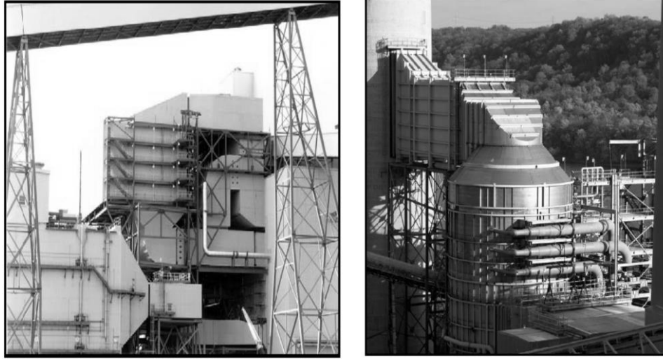
Şekil 2.9. a) 675 MW kapasiteli kömür santralinin SCR sistemi, b) Tipik ıslak FGD sistemi [60].
