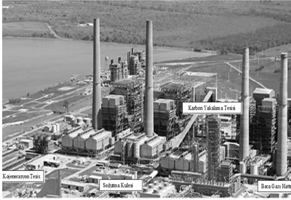
Şekil 1.14. Petra Nova karbon yakalama tesisi [30].
