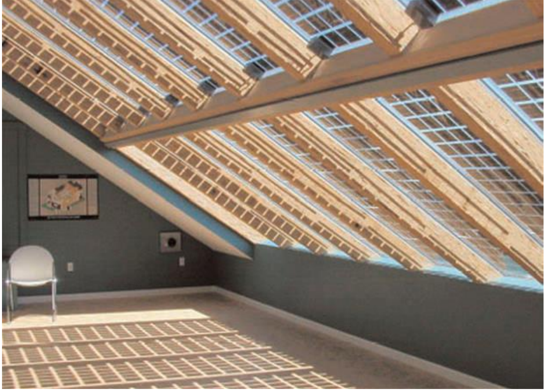
Şekil 2.18. Çatıya entegre edilmiş geçirgen PV modüller [21].
