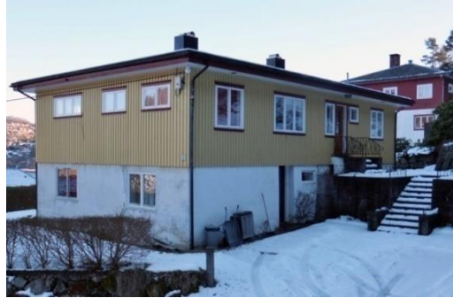
Şekil 4.10. 1930'lar da inşa edilen bir ev, Flekkefjord [56].
