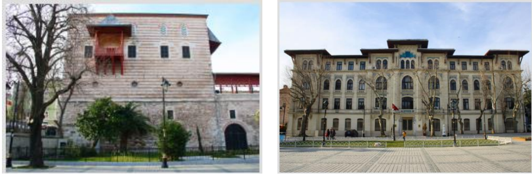
Şekil 3.61. İbrahim Paşa Sarayı ve Defteri Hakanî Binası (Gören, 2020).
