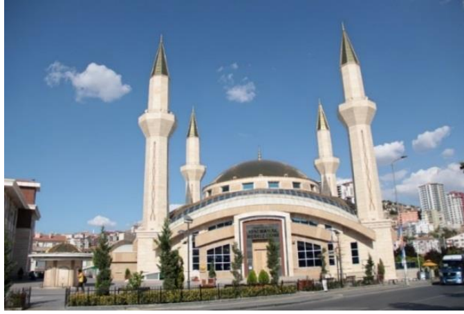
Foto. 204: Mamak Merkez Cami, Batı Cephe, Kişisel Arşiv, 2019.
