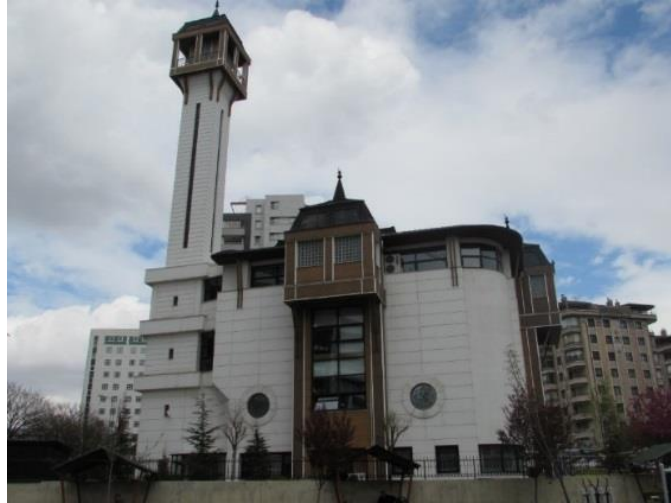
Foto. 165: Hisarcıklođlu Beştepe Cami, Güney Cephe, Kişisel Arşiv, 2019.
