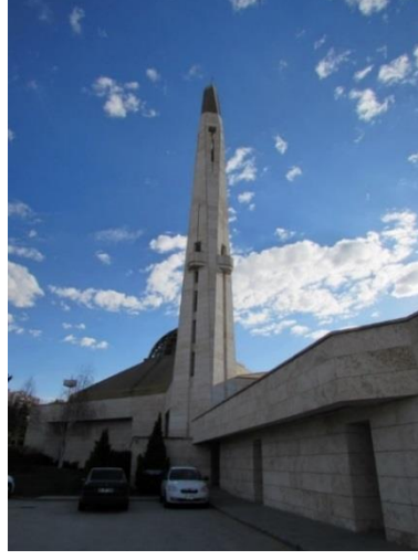
Foto. 152: Doğramacızade Ali Paşa Cami, Minare, Kişisel Arşiv, 2019.
