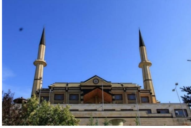
Foto. 153: Türkkonut Merkez Cami, Kuzey Cephe, Kiřisel Arřiv, 2019.
