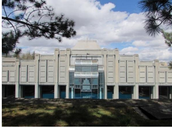
Foto. 126: TBMM Cami, Güney Cephe, Kişisel Arşiv, 2019.
