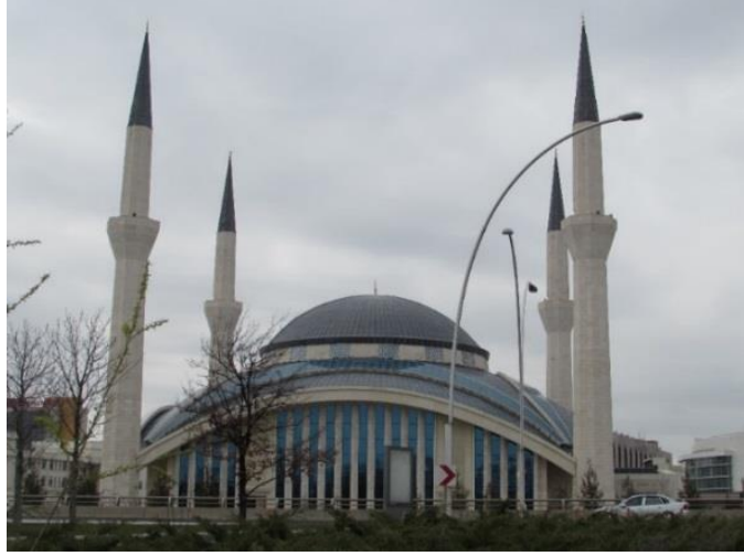
Foto. 190: Ahmet Hamdi Akseki Cami, Doğu Cephe, Kişisel Arşiv, 2019.
