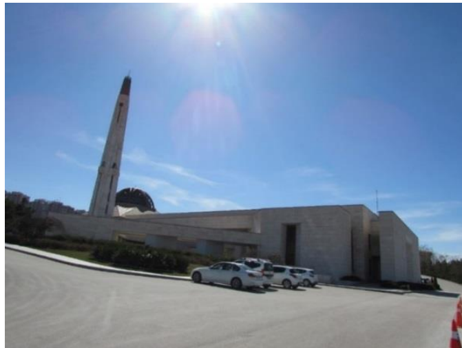
Foto. 145: Doğramacıade Ali Paşa Cami, Doğu Cephe, Kişisel Arşiv, 2019.
