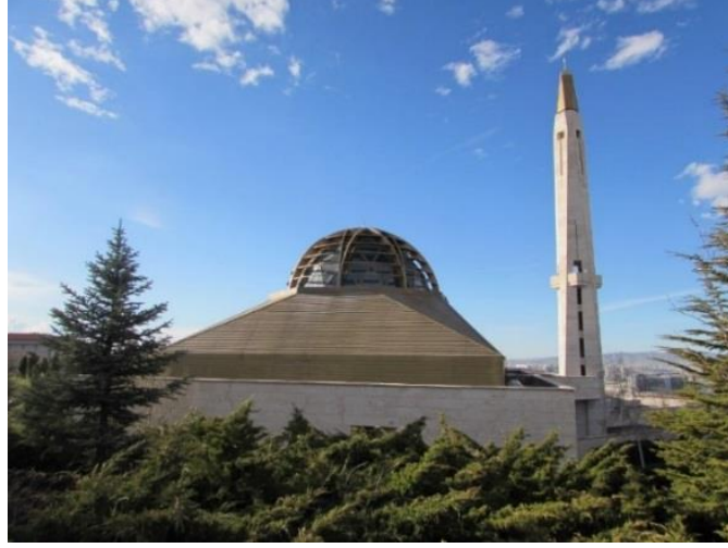
Foto. 146: Doğramacızade Ali Paşa Cami, Güney Cephe, Kişisel Arşiv, 2019.
