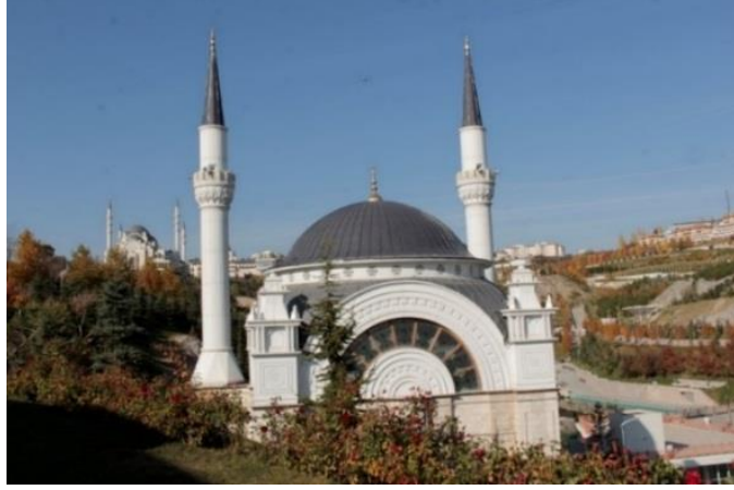
Foto. 183: Niyaziye Cami, Batı Cephe, Kişisel Arşiv, 2019.
