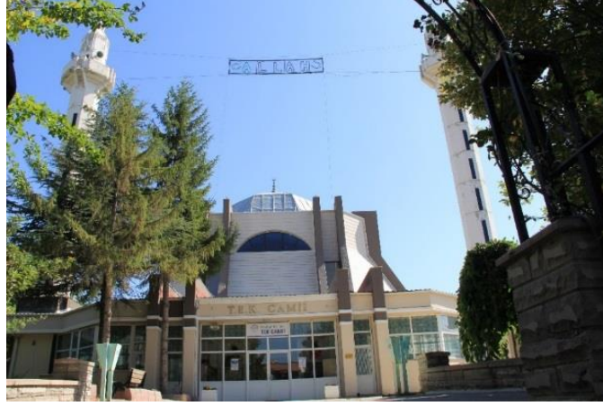
Foto. 115: TEK Camii, Kuzey Cephe, Kişisel Arşiv, 2019.
