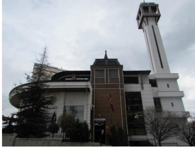
Foto. 162: Hisarcıklıođlu Beştepe Cami, Kuzey Cephe, Kişisel Arşiv, 2019.
