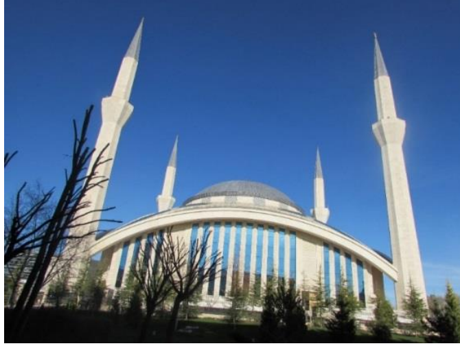
Foto. 192: Ahmet Hamdi Akseki Cami, Batı Cephe, Kişisel Arşiv, 2019.
