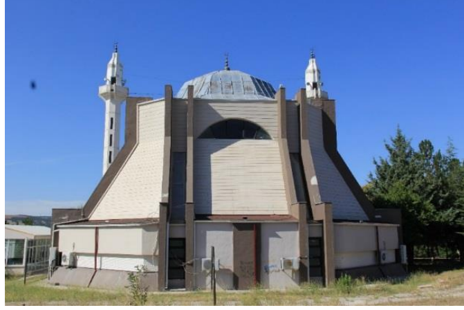
Foto. 117: TEK Cami, Güney Cephe, Kişisel Arşiv, 2019.
