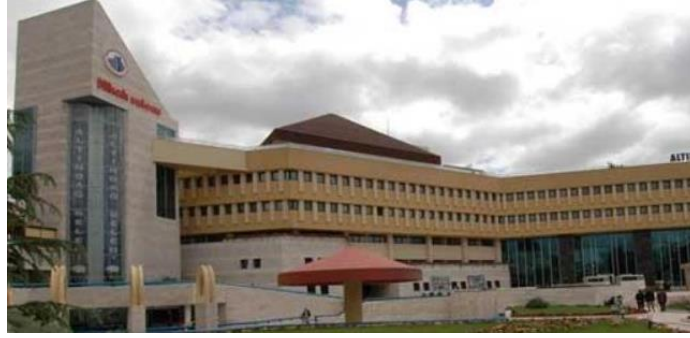
Foto. 90: Altındađ Belediye Bařkanlıđı Binası. ( www.memurlar.net/haber/837036/ , Eriřim Tarihi: 16.01.2020).
