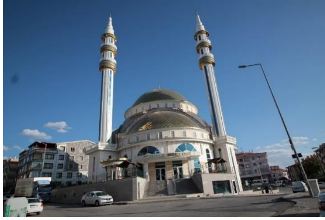
Foto. 211: Güneşevler Merkez Cami, Kuzey Cephe, Kişisel Arşiv, 2019.
