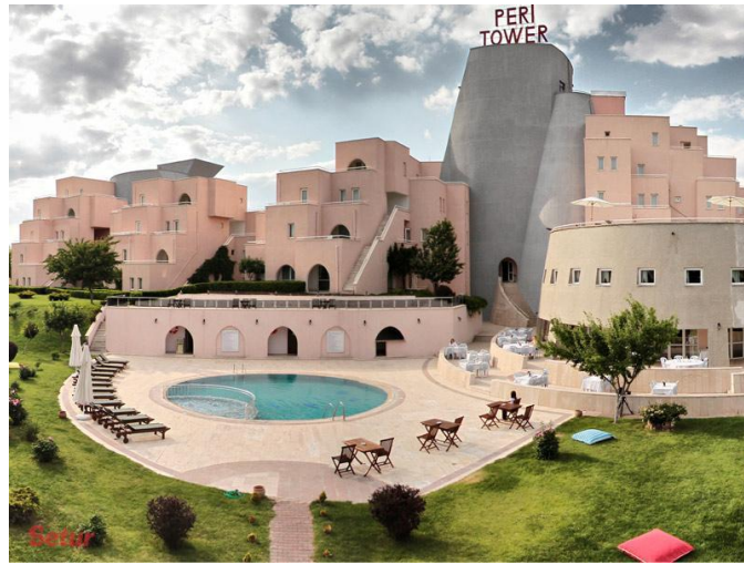
Foto. 102: Peri Tower Otel, Nuran Ünsal ve Merih Karaarslan, 1988-1990. (unsalkaraarslanmimarlik.com/peri-tower-otel.html , Erişim Tarihi: 16.01.2020).
