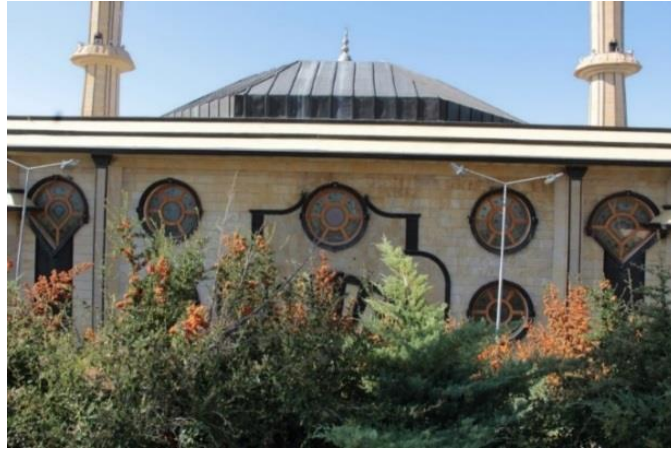
Foto. 155: Türkkonut Merkez Cami, Güney Cephe, Kiřisel Arřiv, 2019.
