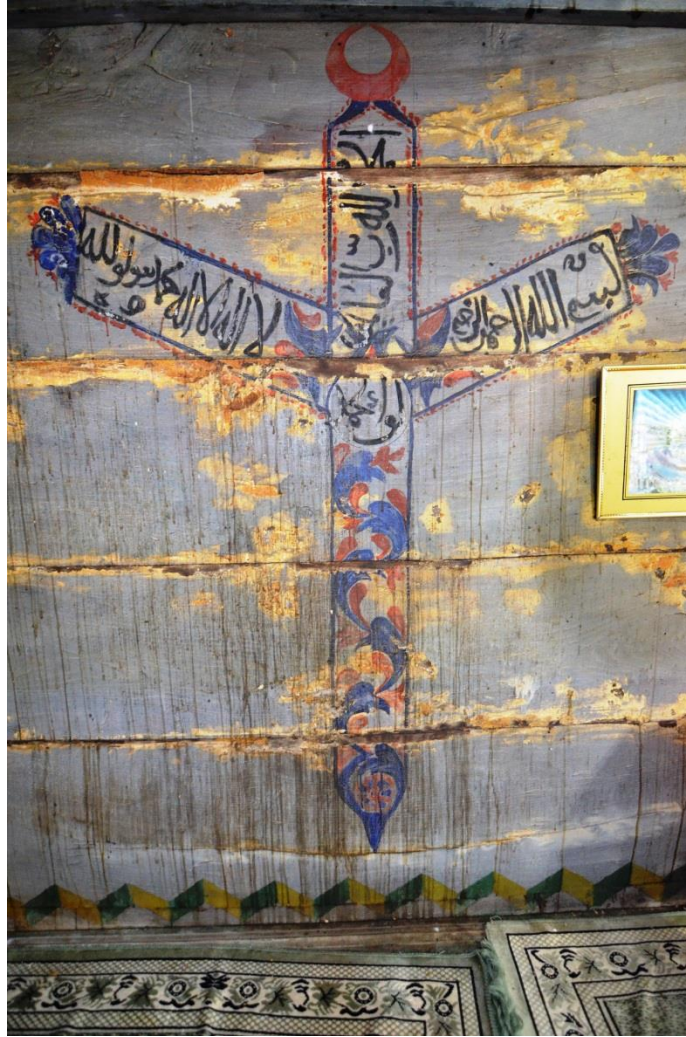
Fotograf 94. Ardeşen Doğanay Köyü Camii güney duvar (Eylül, 2018).
