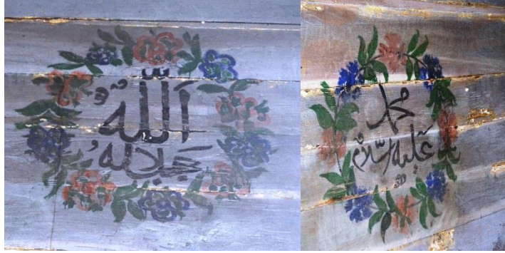
Fotograf 98. Ardeşen Doğanay Köyü Camii Mahfil Katı güney duvar süsleme (Eylül, 2018).
