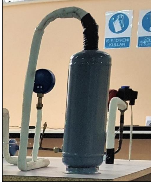
Şekil 4.12. Düşük sıcaklık devresi sıvı tutucusu (akümülatör).
