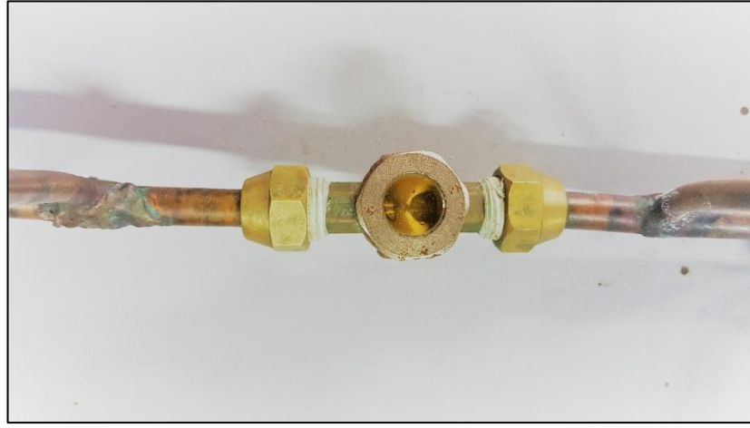
Şekil 4.8. Gözetleme camı.
