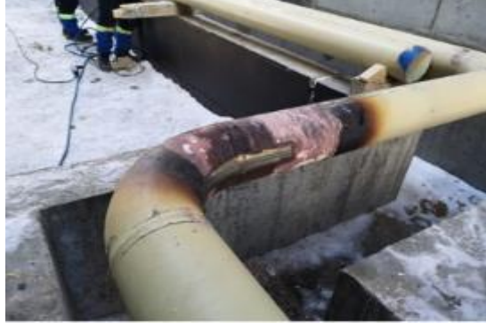
Şekil 2.5. Kaynaklı Boru Montajı- GazpromNeft Onpzd CDU/VDU Complex Project Rusya/Omsk Oblast.
