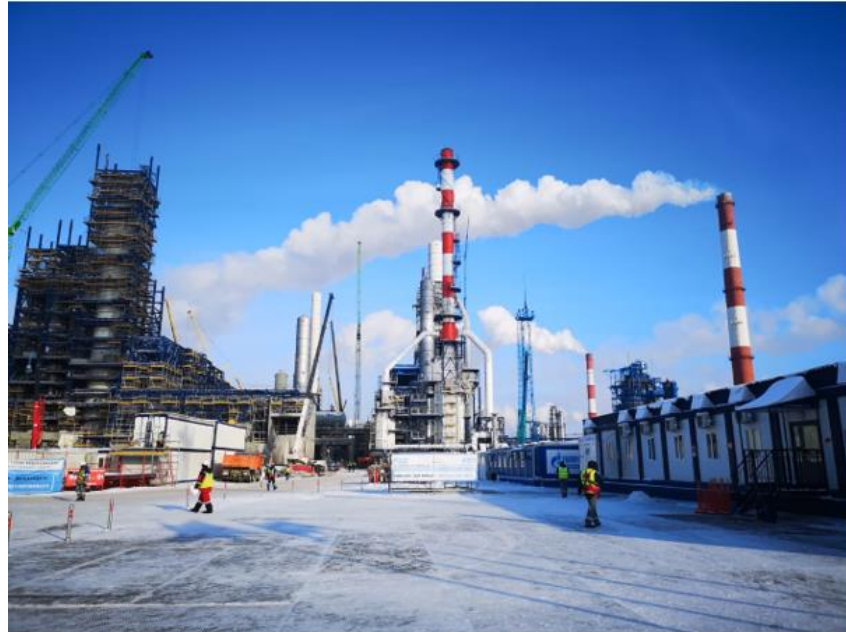
Şekil 2.4. Petrokimya Rafineri Şantiyesi- GazpromNeft Onpz CDU/VDU Complex Project Rusya/Omsk Oblast.
