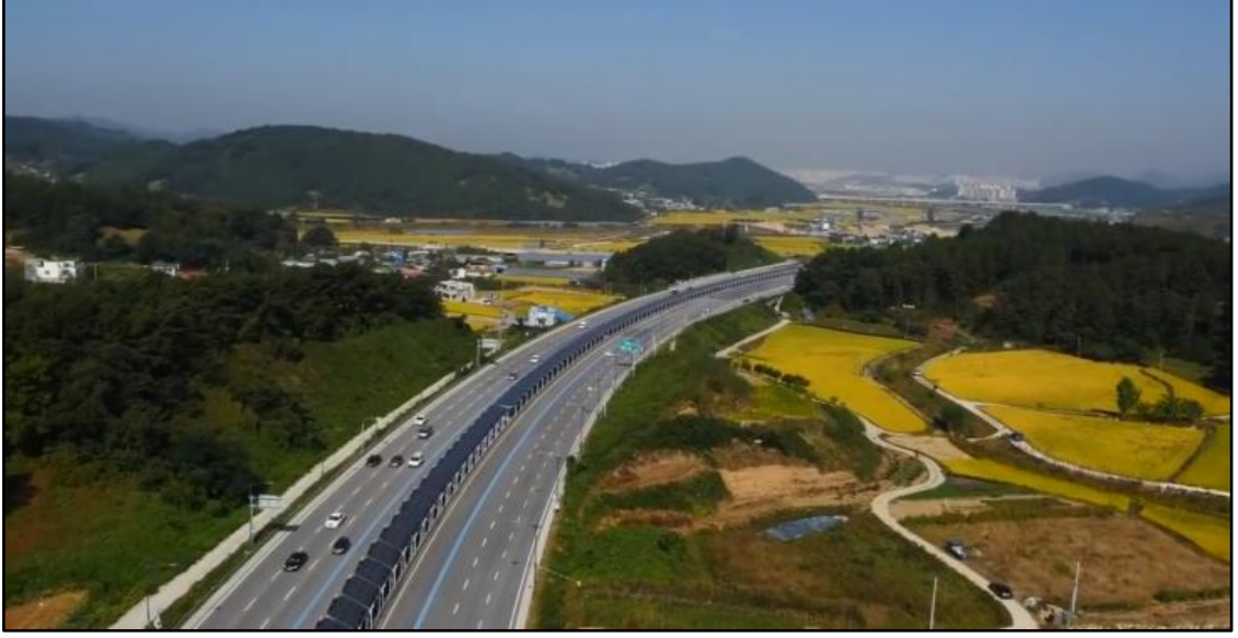
Fotoğraf 6. Güney Kore’de Bisikletli Otoyolun Çatısına Yerleştirilen Güneş Panelleri 41 .
