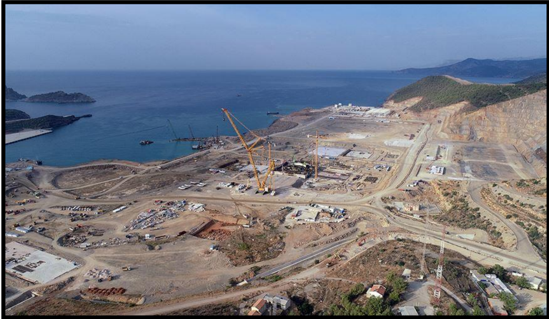
Fotoğraf 2. Akkuyu Nükleer Güç Santrali Alanı (URL 2)
