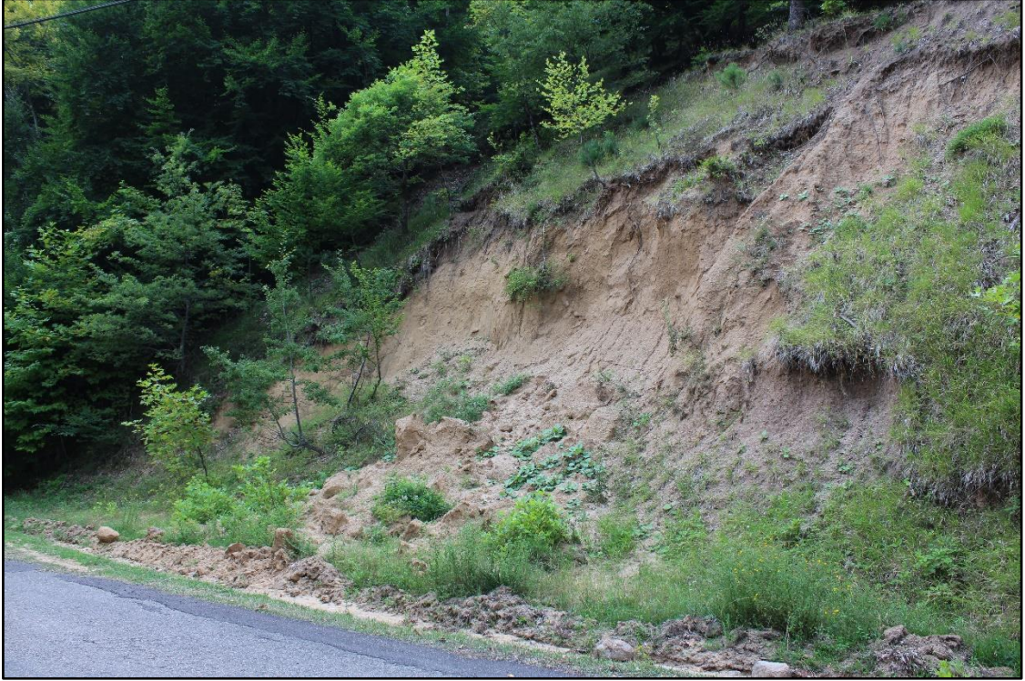
Fotoğraf 5. Yeşilköy civarında yol kenarında gerçekleşmiş küçük bir heyelan.
