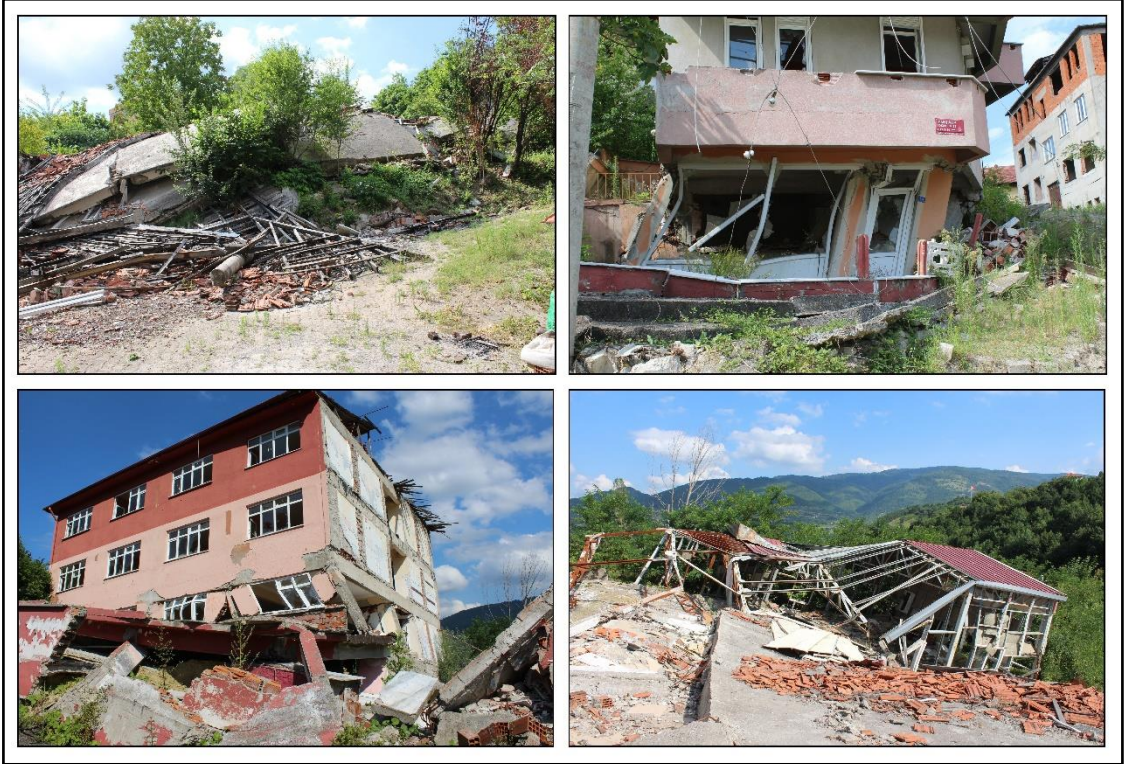
Fotoğraf 7. 16 Temmuz 2015'te gerçekleşen Devrek heyelanında zarar gören binalar.
