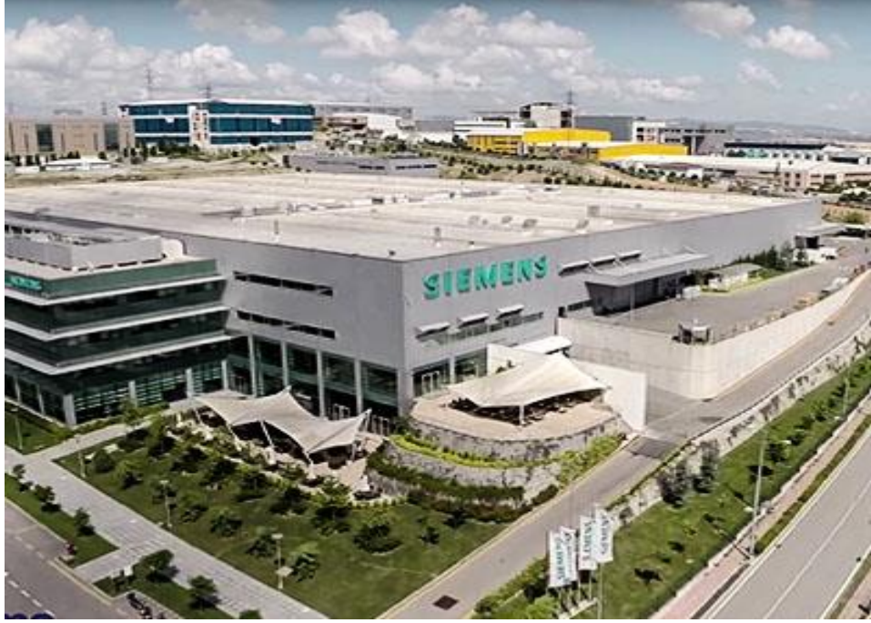
Şekil 2.31. Siemens Gebze fabrikası [59].
