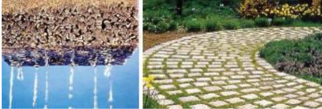
Şekil 2.13. Zemine yeraltı suyu geçirgenliği sağlayan taş döşenmesi örnekleri [35].
